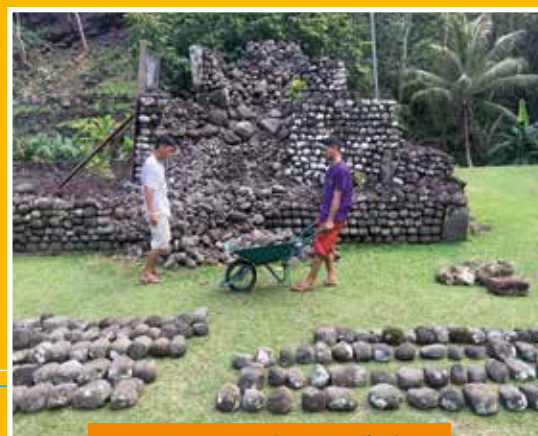
Rangement et triage des pierres effondrées
