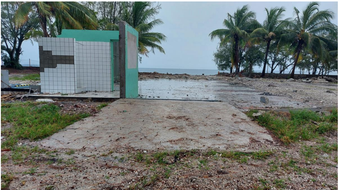
Figure 1: Dallage et structure hangar vue 2
