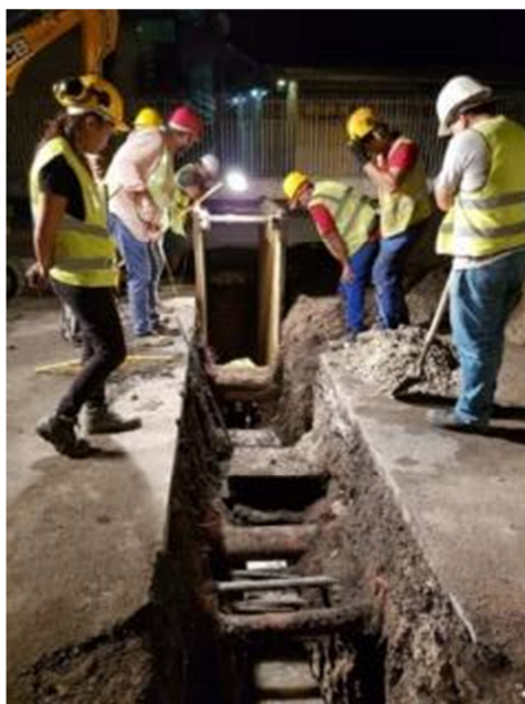
Illustration 27 : Travaux d'assainissement de la commune de Papeete, Papeete, 15 mars 2018 – Source : Société Interoute
