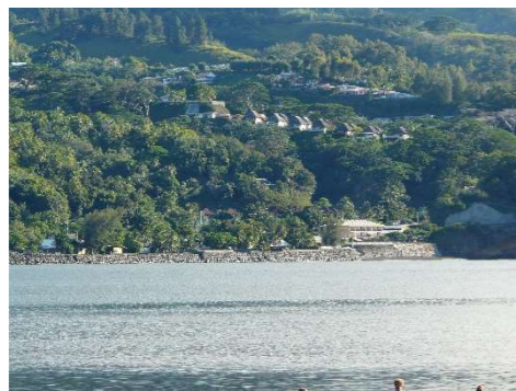
Enrochements en bas du Taharaa
