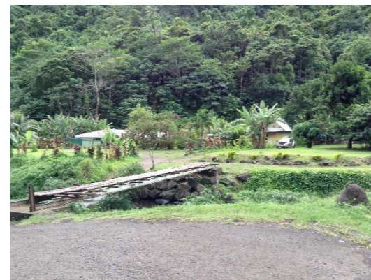
Habitations accessibles par un pont précaire
