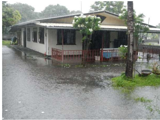
Inondation d'une habitation dans le secteur de la pointe Vénus
