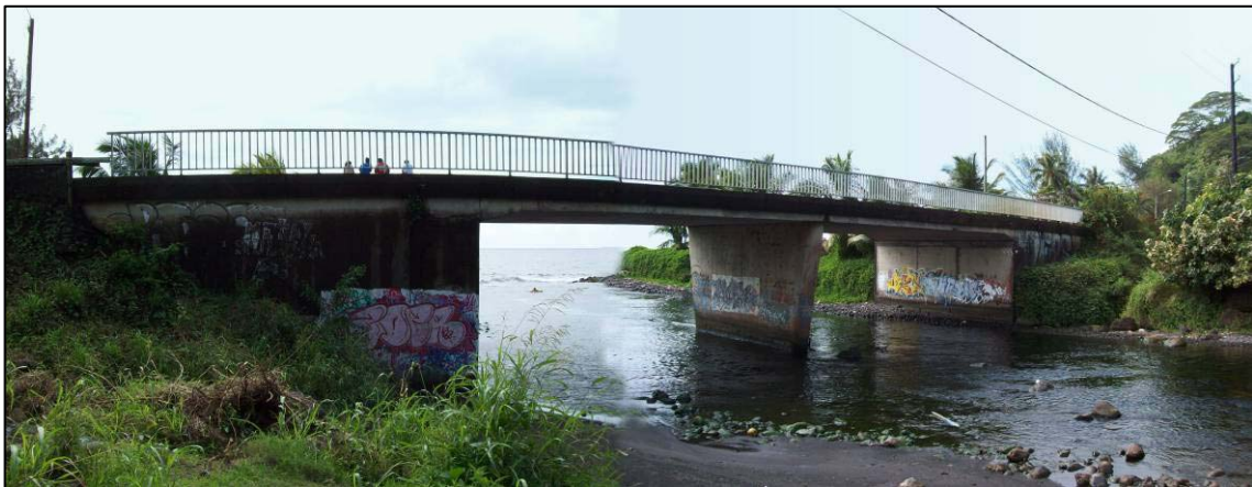
Le pont de la RT1 sur l'Onohea au niveau de l'embouchure
