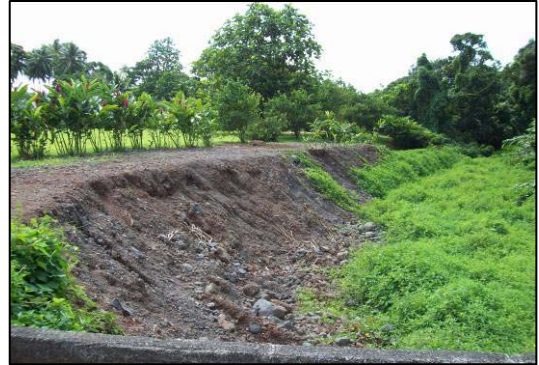
Remblai de terrain en bordure du chenal de crue
