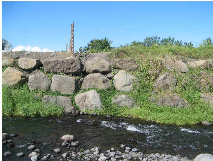
Photographie n°2 : Exemple de protection de berges de la TAHARUU (source EGIS Eau)
