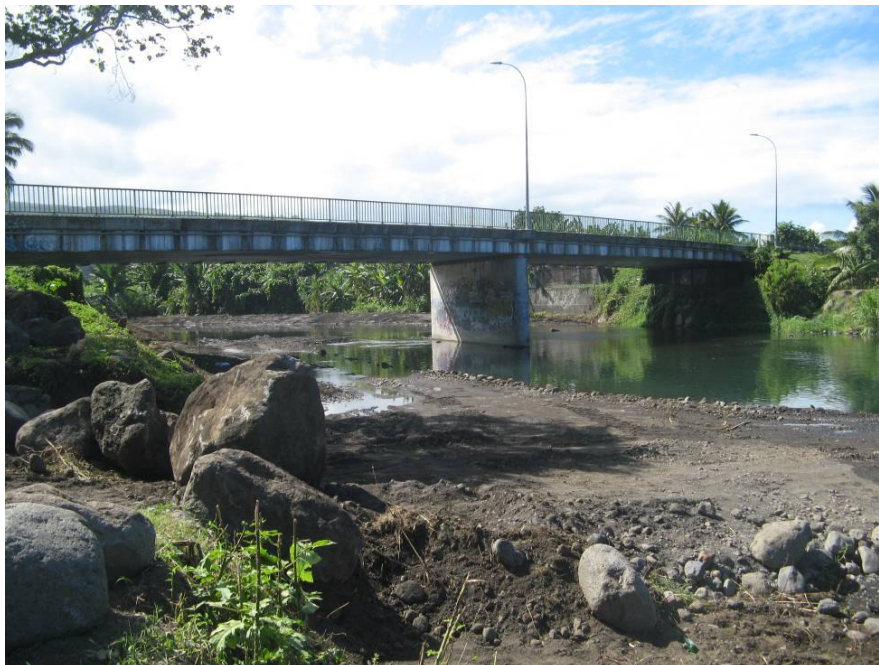
Photographie n°4 : Pont de la route de ceinture (source EGIS Eau)
