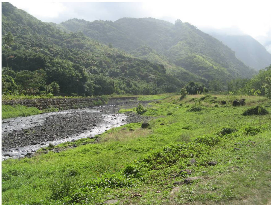
Photographie n°1 : Recalibrage de l'amont du lit mineur de la TAHARUU (source EGIS Eau)
