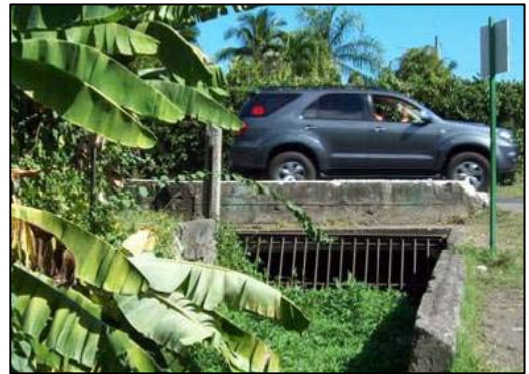
Le pont de la RT2
