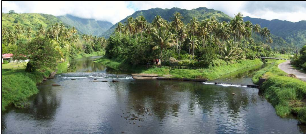
Les seuils au niveau de la confluence de la Tévaifaara et de la Mahape vus depuis le pont de la RT1
