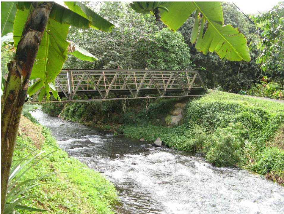
Photographie n°1 : Passerelle sur la VAIHIRIA en amont de la zone d'étude (source EGIS Eau)
