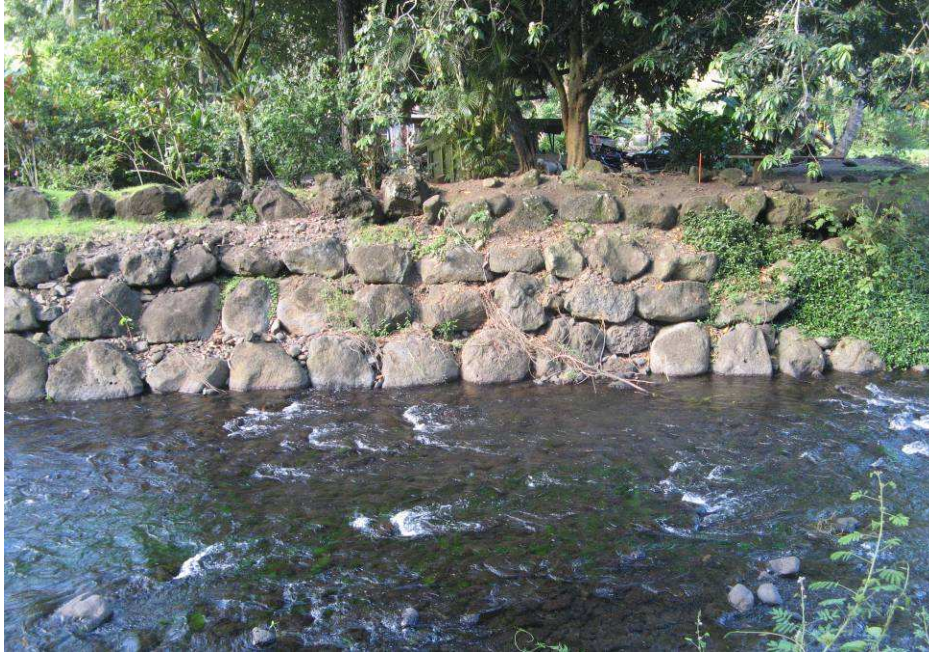
Photographie n2 : Protection des berges de la VAIH IRIA en amont (source EGIS Eau)
