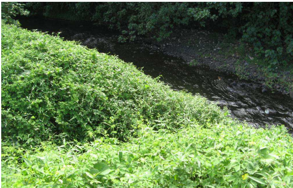
Photographie n°5 : passage dans la digue latérale ( source EGIS Eau)
