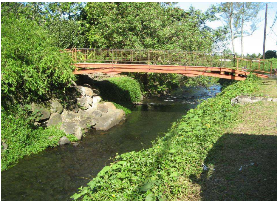
Photographie n3 : Passerelle métallique en amont de la VAIHIRIA (source EGIS Eau)
