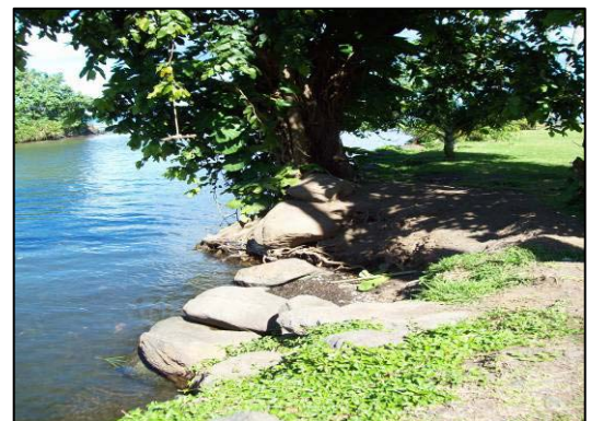
Sapement de pied des enrochements
