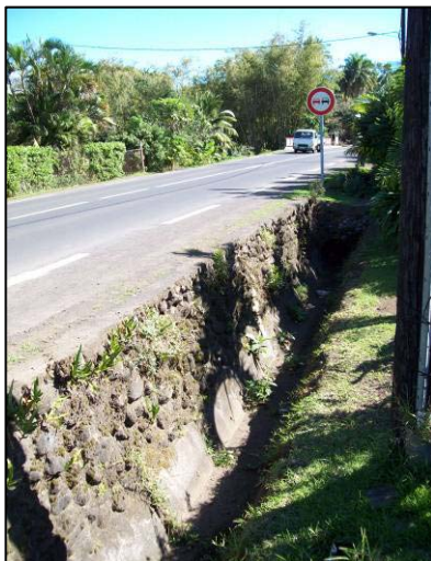
Fossé collecteur le long de la RT2
