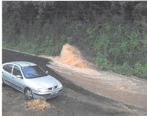
Perte de charge au droit d'un exutoire colmaté
