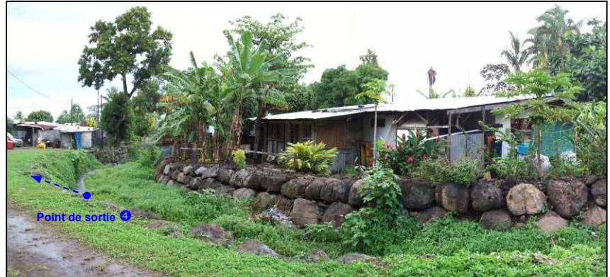
Habitations exposées de part et d'autre des berges.
