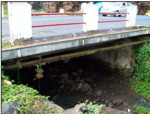
Ouvrage hydraulique limitant sur la RT2
