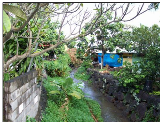
Exutoire du chenal en aval de la RT
