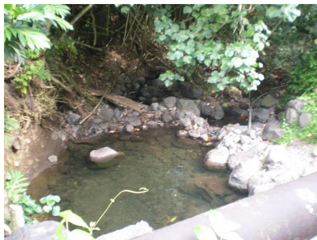
Photo 2 : Vue aval ouvrage
