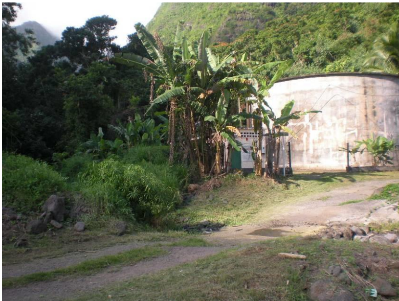
Photo 3 : Radier d'accès à l'usine de chloration
