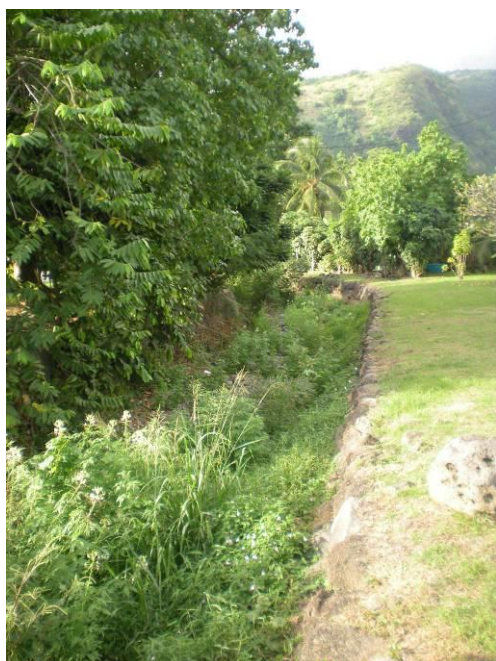
Photo 10: Vue du lit amont
