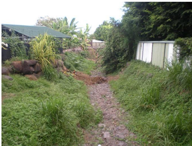
Photo 13 : Vue aval pont RT
