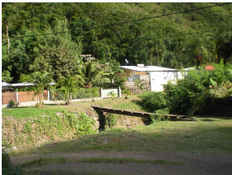
Photo 5 : Passerelle aval radier
