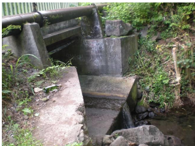
Photo1 : Ouvrage de franchissement amont
