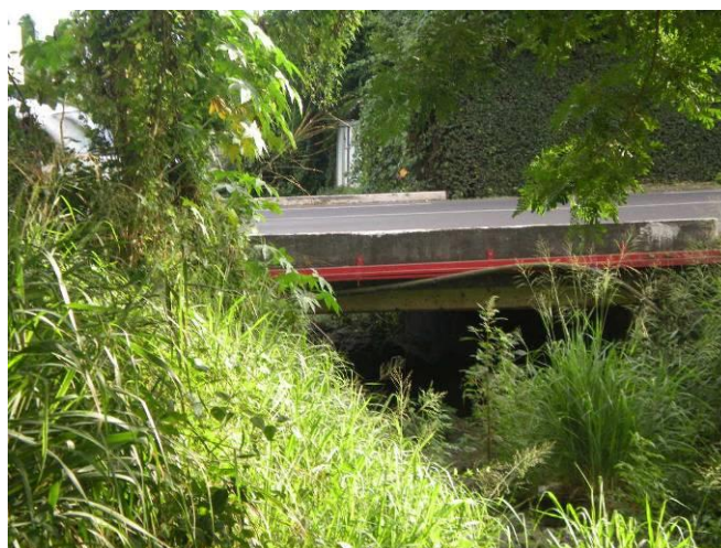
Photo 11 : OA franchissement RT (vue amont)
