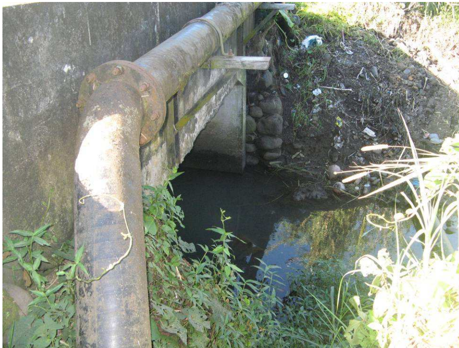
Photographie n°10 : Cadre sous la route de ceinture (source EGIS Eau)
