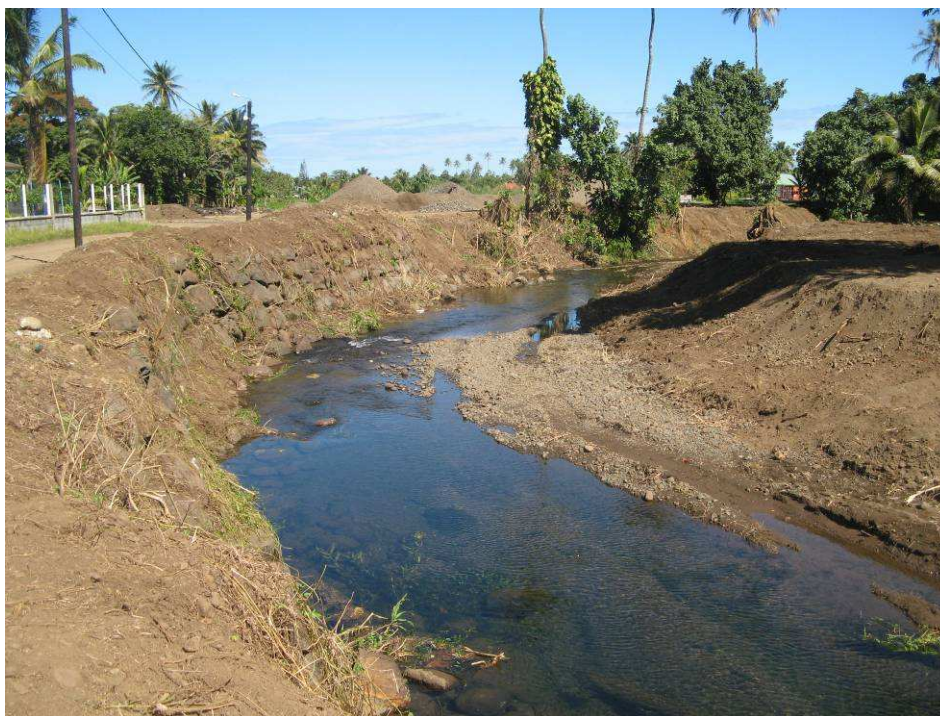
Photographie n°3 : Recalibrage du lit mineur de la PAUI (source EGIS Eau)
