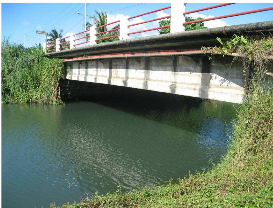
Photographie n°9 : Pont de la route de ceinture de la TITAAVIRI (source EGIS Eau)
