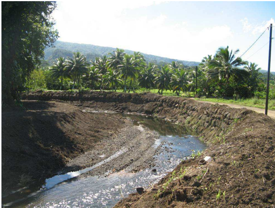
Photographie n°2 : Recalibrage du lit mineur de la PAUI (source EGIS Eau)
