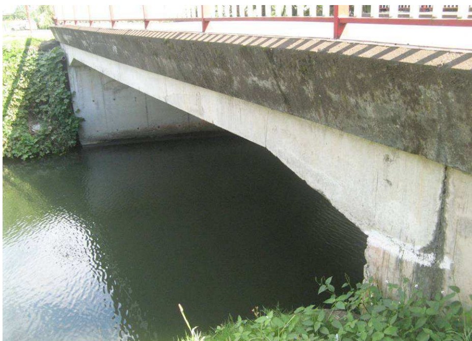
Photographie n°5 : Pont de la route de ceinture de la PAUI (source EGIS Eau)
