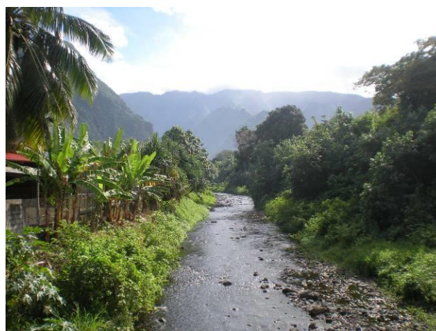
Photo 2 : Vue amont ouvrage
