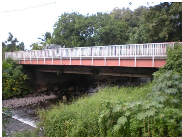
Photo 1 : Franchissement de la RT
