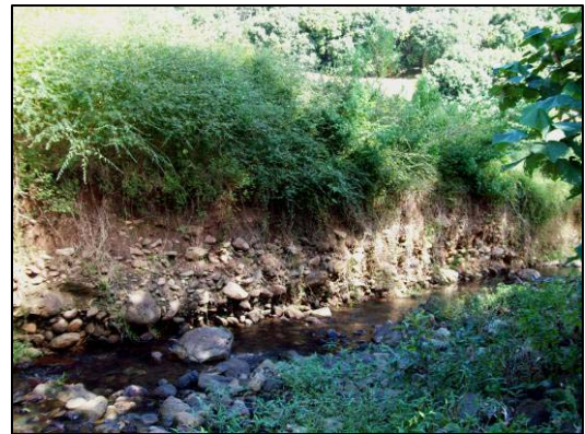
Erosion et sapement du pied de berge rive gauche
