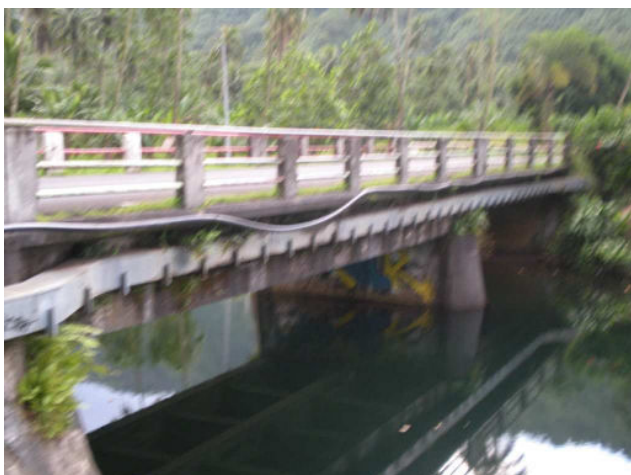
Photo 1 : Franchissement de la RT
