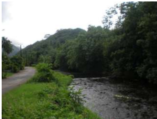
Photo 8 : Affaissement de berge
