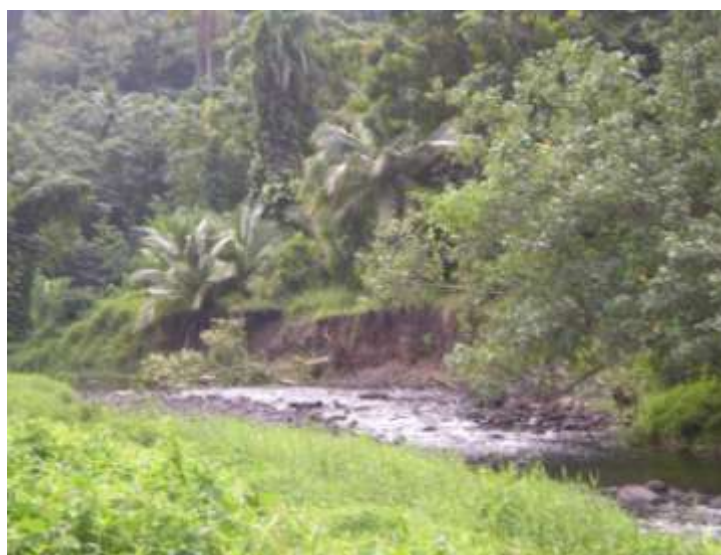
Photo 10 : Erosion en rive gauche
