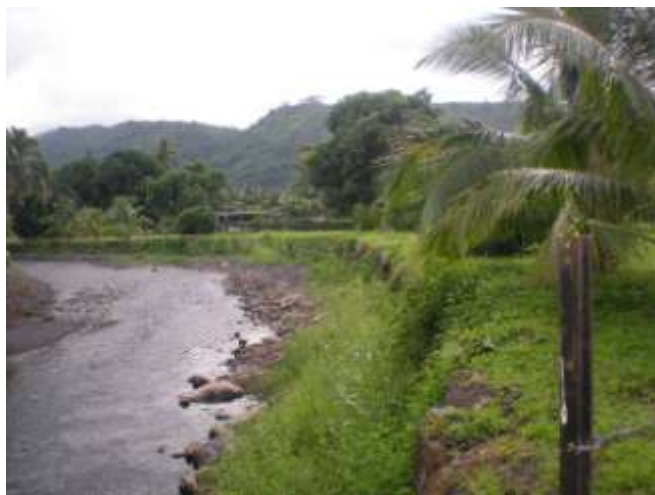
Photo 4 : Vue protections aval rive gauche
