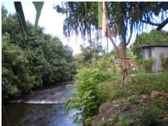
Photo 7 : berge protégée en RD
