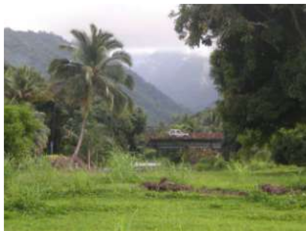
Photo 2 : Vue aval ouvrage
