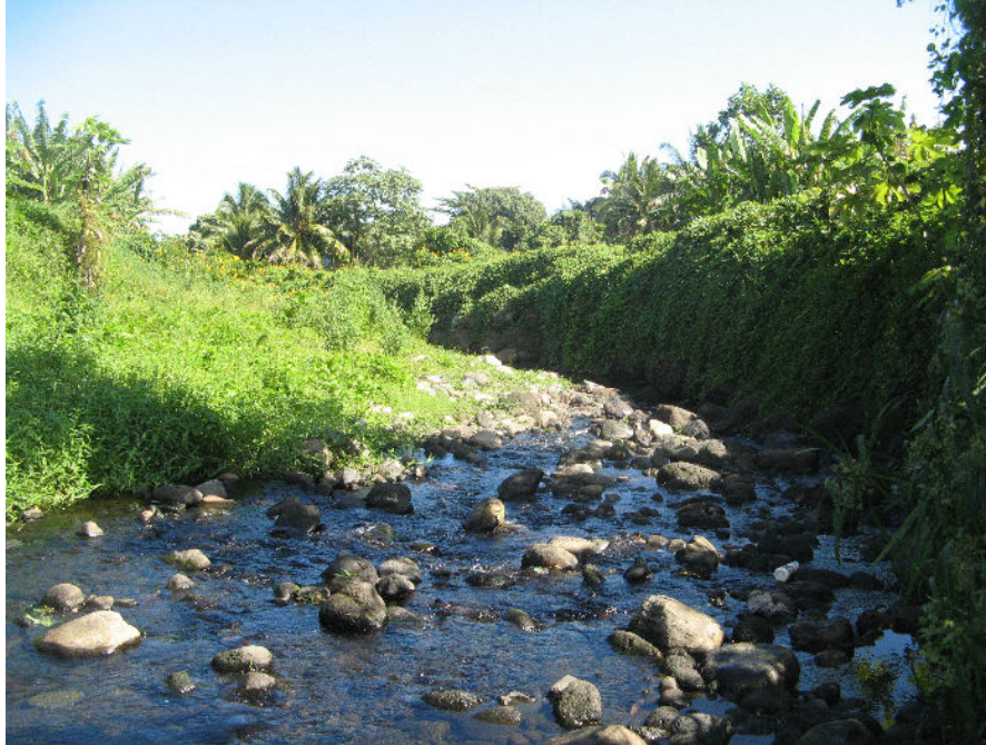
Photographie n°4 : Lit mineur endigué en aval du pont de la route de ceinture (source EGIS Eau)
