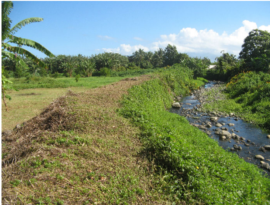
Photographie n°3 : Berge endiguée en rive gauche en aval de la route de ceinture (source EGIS Eau)
