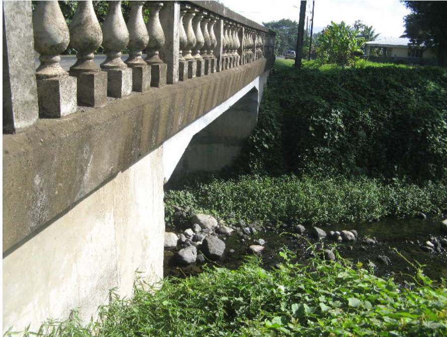
Photographie n°2 : Pont de la route de ceinture (source EGIS Eau)
