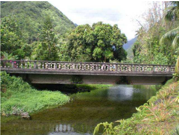
Photo 1 : Franchissement de la RT
