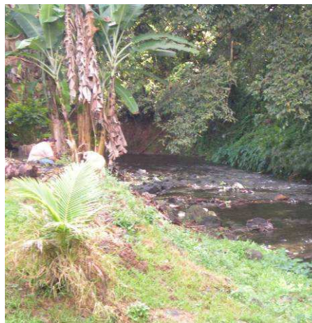
Erosion du versant provoquant les éboulements
