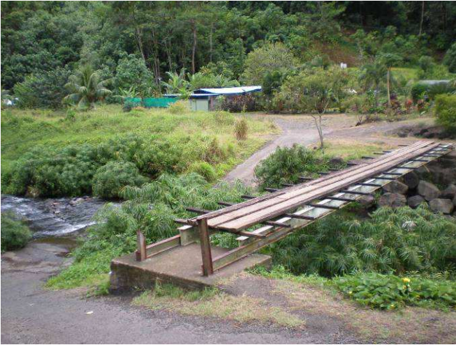
Photo 19: Radier n°4 et passerelle
