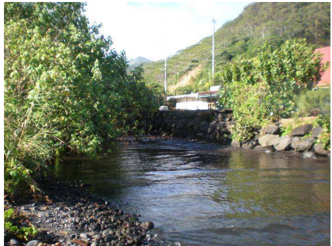
Photo 2 : Vue aval pont RT
