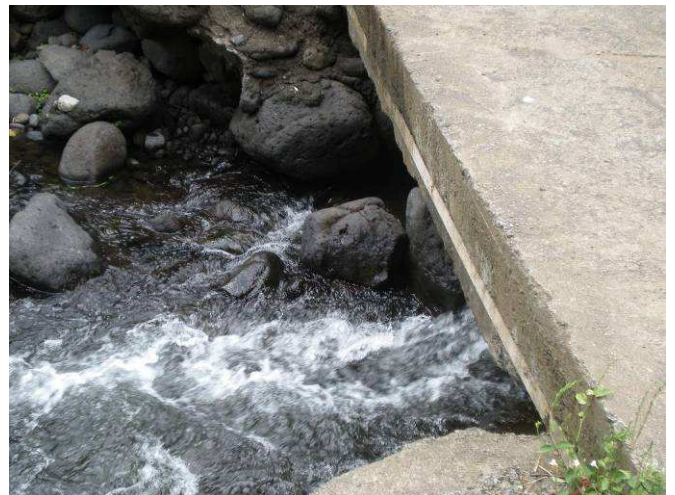
Photo 22 : Détail de l'ouvrage.
