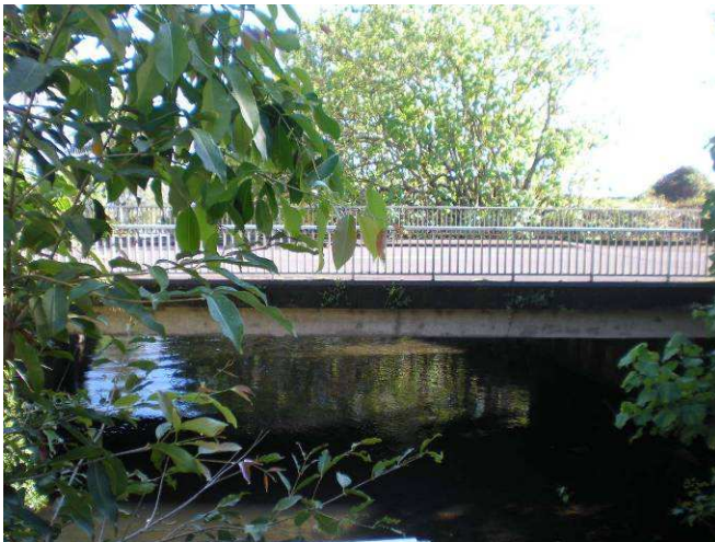
Photo1 : Franchissement de la RT (PT3)
