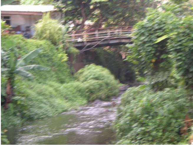
Photo 7 : Vue aval premier coude. Pont PT9
