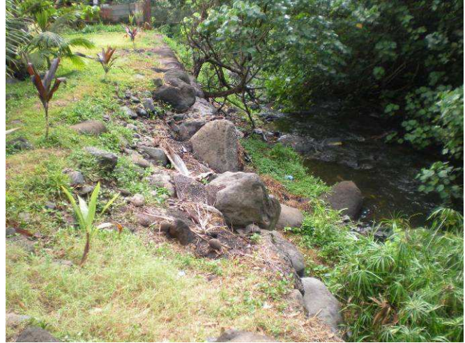
Photo 12 : Protection affaissée.
