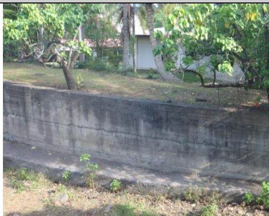
Digue composée d'un mur en béton armé renforcé par un remblai de terre d'épaisseur = 3 m
