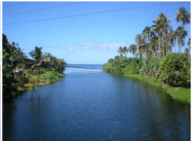
Photo 2 : Vue aval pont RT
