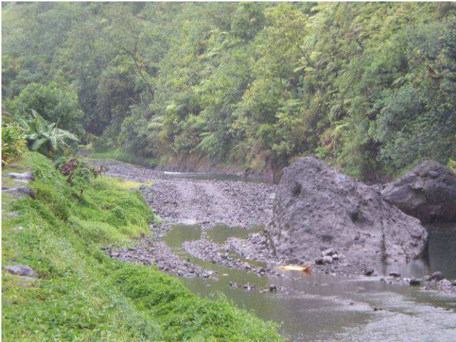
Photo 10: Chute de blocs dans le lit
