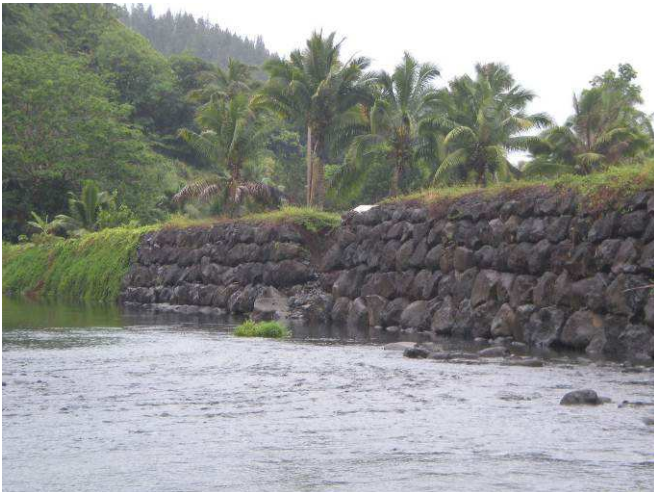
Photo 8 : Destruction de la protection existante
