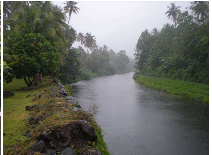
Photo 5 : Rive droite amont pont
