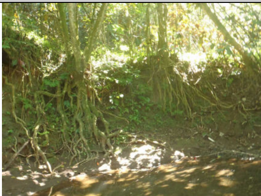
Berges érodées en rive droite avec mise à nu du système racinaire
