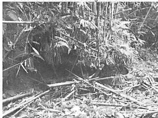
Erosion sous le bouquet de bambous en RG
