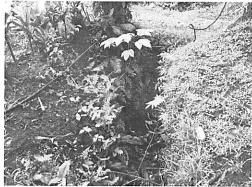
Fossé à l'aval de la piste vu de l'aval
