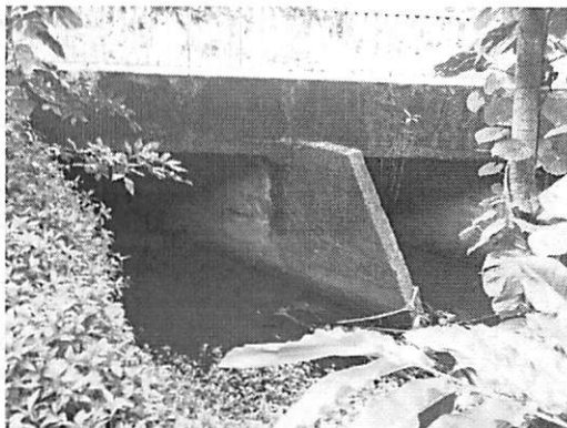
Pont de la RT2 vu de la berge RG amont
