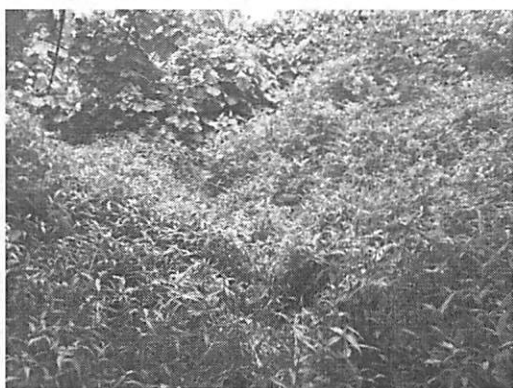
16- Lit envahi par la végétation en AT du coude vu de l'AL
