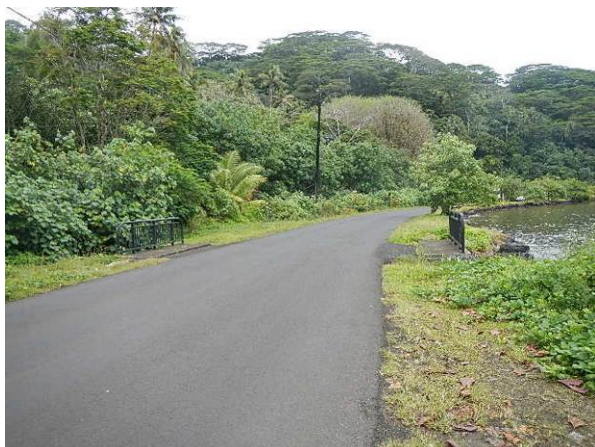
Photo1 : Franchissement de la RT
