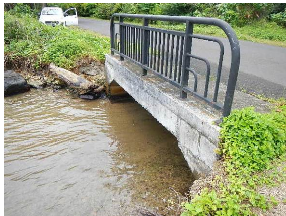
Photo 2 : Pont de la RT : Vue aval
