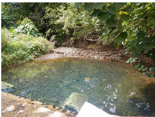
Photo 11 : Affouillement aval radier R2 Photo 12 : Radier provisoire
