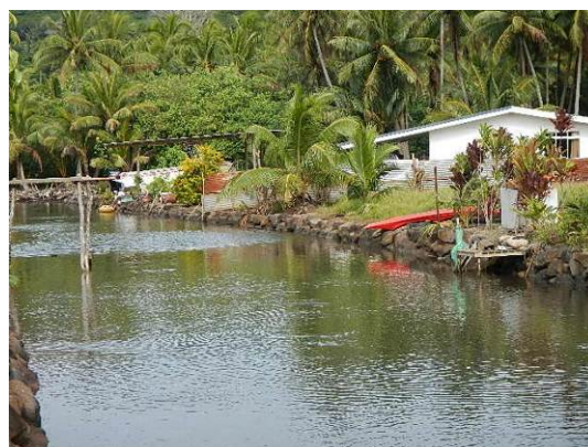
Photo 6 : vue amont de l'ouvrage
