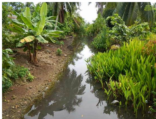
Photo 4 : vue aval de l'ouvrage
