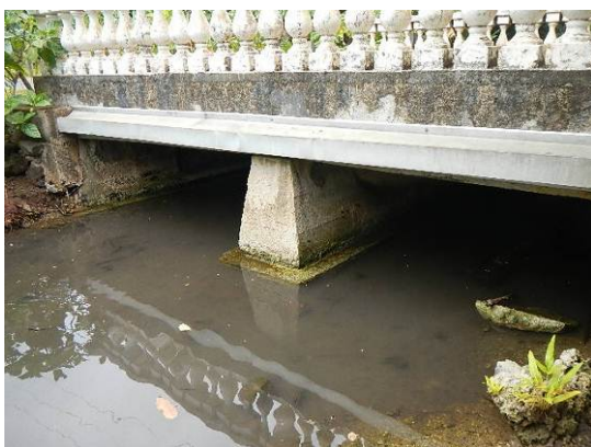
Photo 3 : OH2, décharge rive gauche
