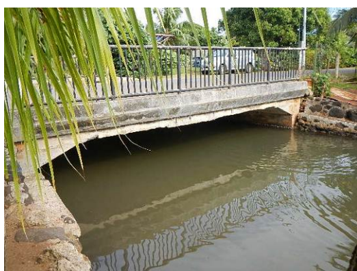
Photo 5 : OH3, décharge rive droite
