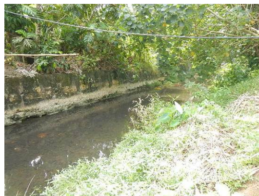
Photo 9 : Radier R1 accès à la rive gauche Photo 10 : Sous-cavement de l'endiguement
