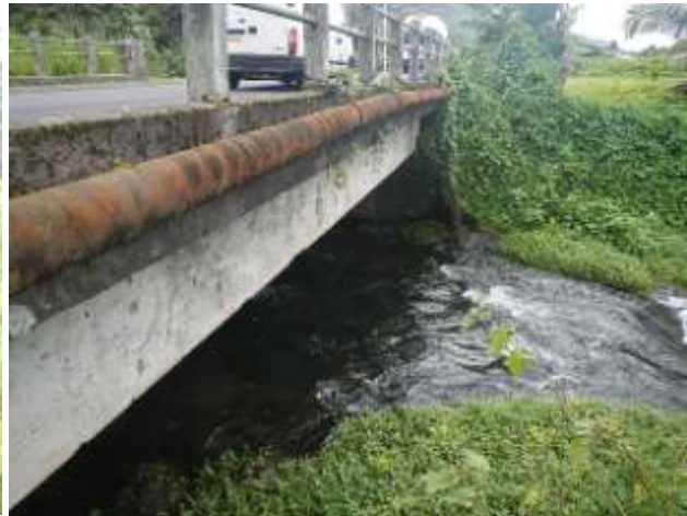
Photo 2 : Pont de la RT vue aval
