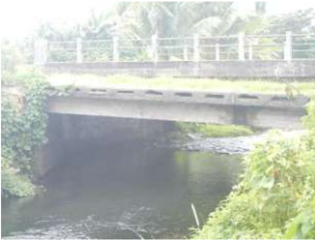
Photo 1 : Pont de la RT vue amont
