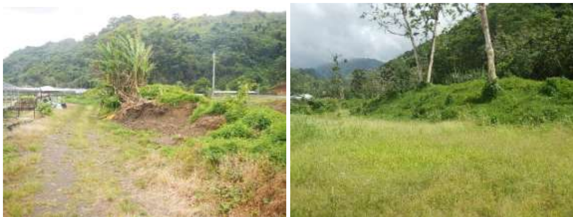
Photo 7 et 8 : Levée de terre rive droite en bordure des serres
