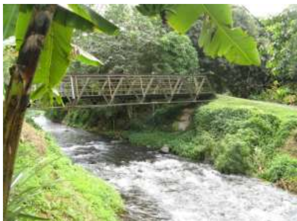
Photo 14: Vue aval deuxième passerelle
