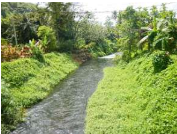
Photo 15 : Section protégée en amont de la passerelle
