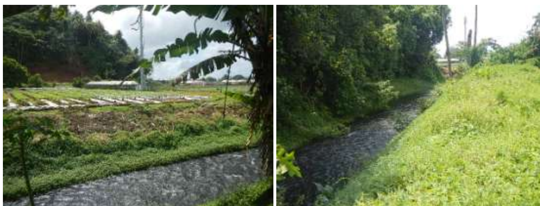
Photo 9 et 10 : Vue de la rive gauche
