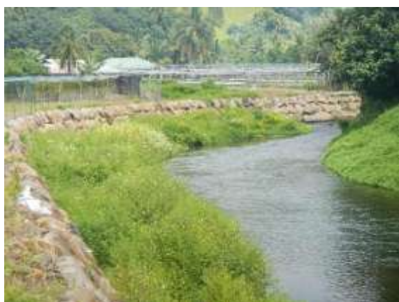
Photo 6 : Protection du 1 o méandre amont RT
