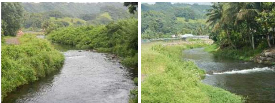
Photo 4 et 5: Vue amont pont RT
