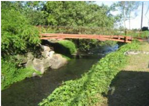
Photo 12 : Vue amont première passerelle
