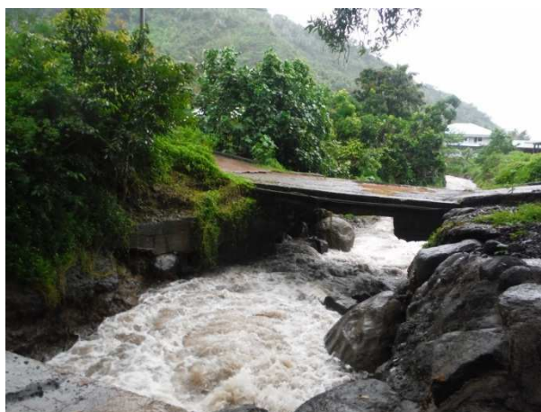
Figure 2 : ancien radier ressemblant à un pont aujourd'hui – PT 6
