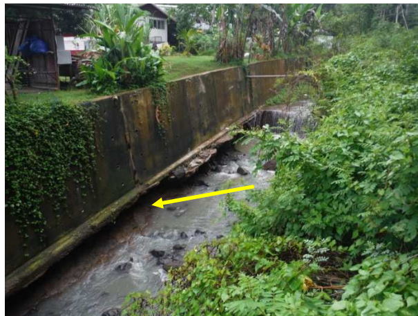
Figure 6 : exemple de départ d'érosion en pied de berge sur la MAKE MAKE (rive gauche pt 1.2)
