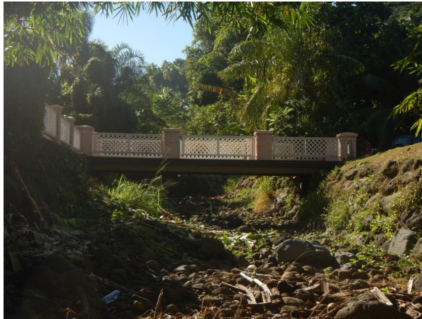
Figure 16: Passerelle construite en ciment pour un accès privé. Vue vers l'amont.
