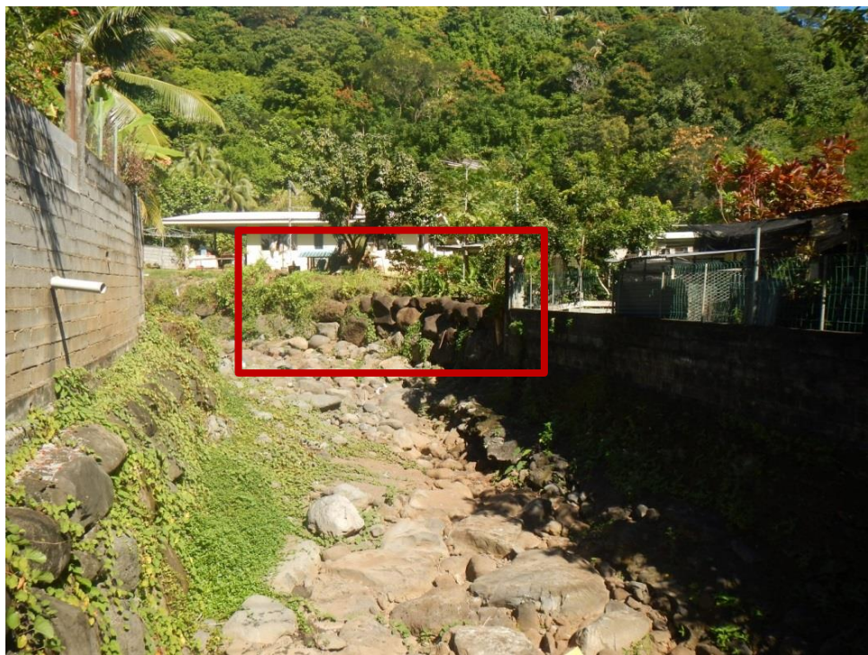
Figure 35 : Ligne droite canalisée entre deux virages serrés. Le rectangle rouge attire l'attention sur un point de vulnérabilité de la berge concave, les débordements y sont fréquents.
