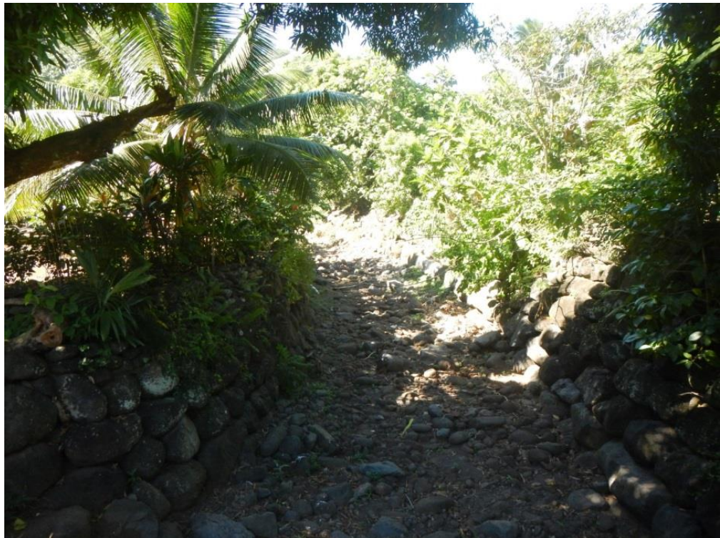
Figure 27 : Vue vers l'amont à partir de la passerelle 11.
