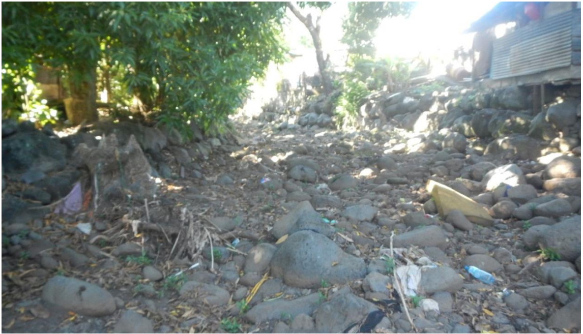
Figure 9 : Tronçon T2 du cours d'eau présentant une très faible pente. Les éléments solides s'accumulent rehaussant le lit et menaçant des berges sommairement enrochées.
