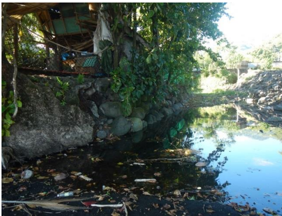
Figure 13 : Embouchure rive droite, vue vers l'amont.
