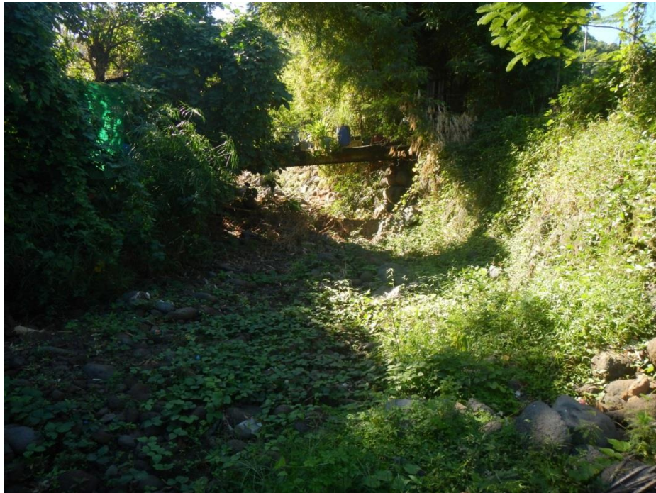
Figure 15 : Passerelle instable traversant le lit de la rivière.
