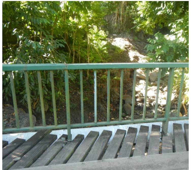
Figure 42 : Vue vers l'amont du lit au-delà de la dernière passerelle.
