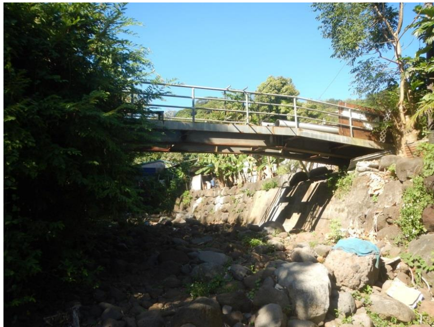
Figure 22 : Passerelle métallique abandonnée. Vue vers l'amont
