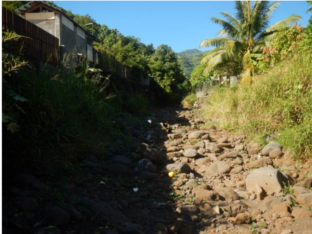
Figure 19 : Tronçon à l'amont du pont de la route territoriale.
