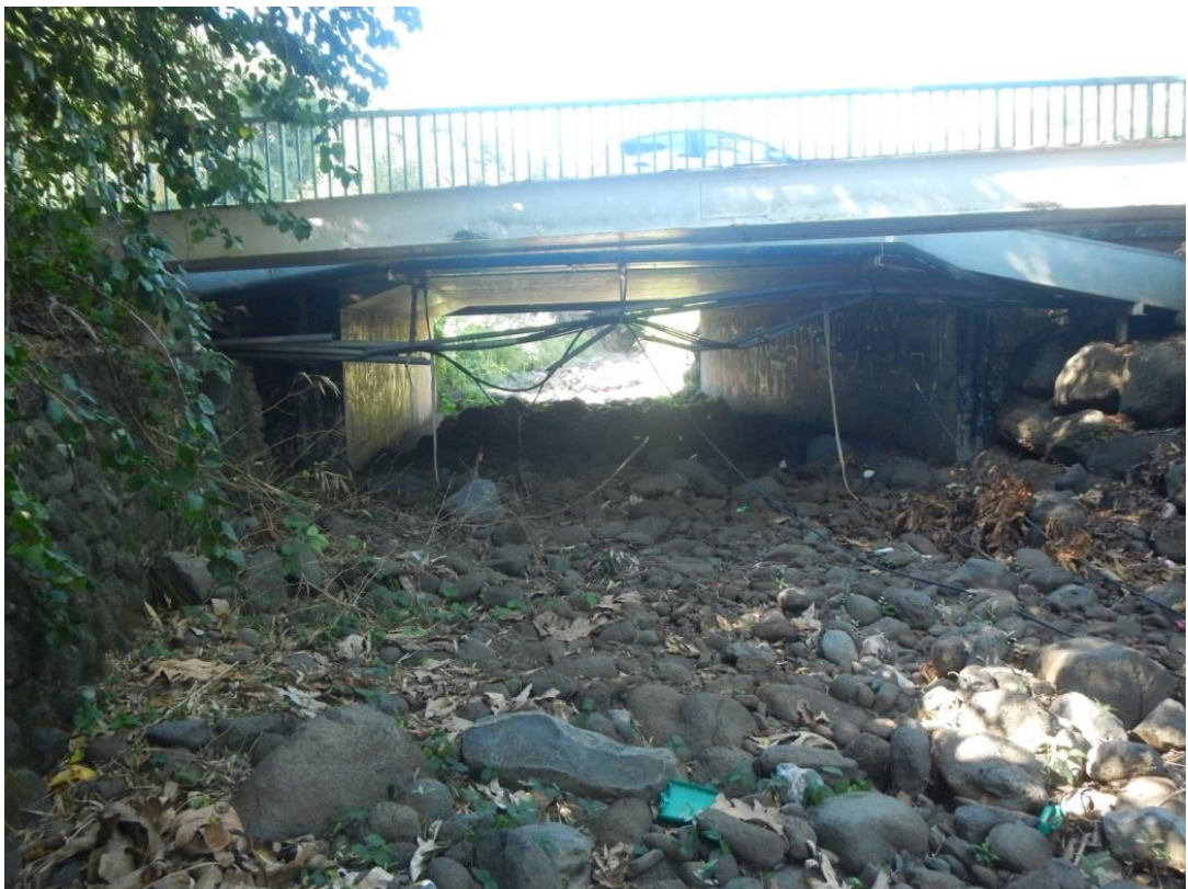
Figure 18 : Pont sous la route territoriale RT2. Vue vers l'amont.
