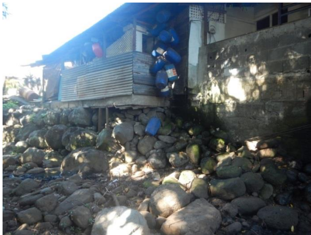
Figure 24 : L'habitation est sous la menace imminente d'un affaissement de la berge.
