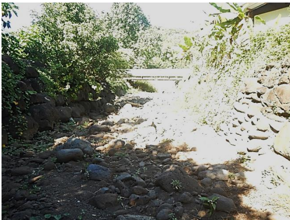
Figure 20 : Passerelle traversant la rivière.
