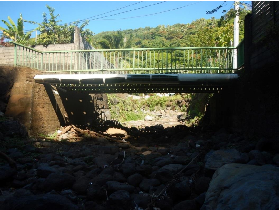
Figure 33 : Passerelle portant la route d'accès au fond de vallée. Vue vers l'amont.
