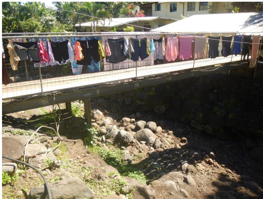
Figure 28 : Passerelle privée pour connecter deux terrains d'une même famille.
