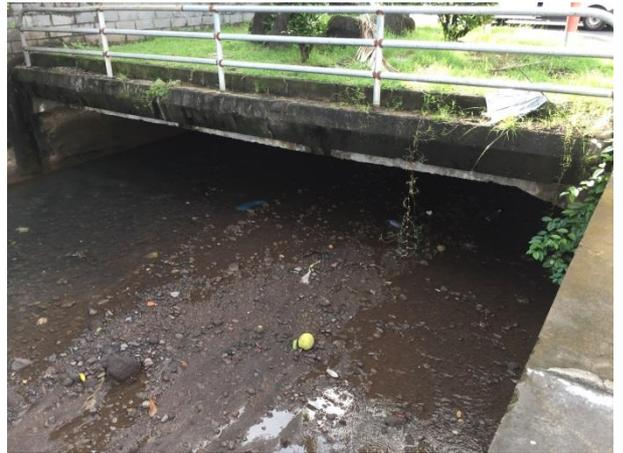
Figure 18 : Sortie aval du tronçon recouvert.
