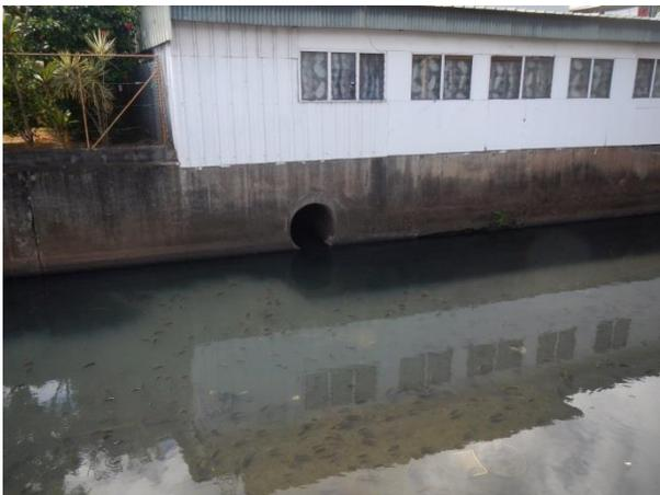
Figure 19 : Déversement d'une buse d'assainissement des eaux pluviales.
