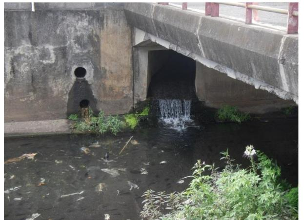
Figure 20 : Connexion du système d'assainissement d'eau pluviale d'un quartier mitoyen.
