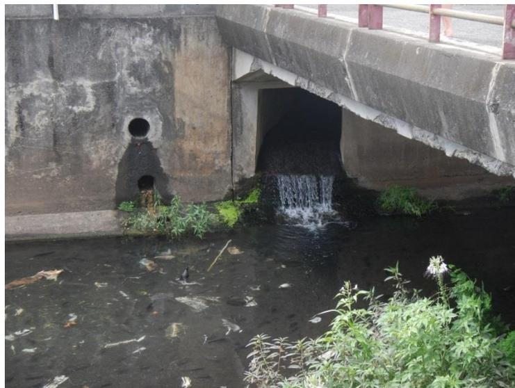
Figure 32 : Exutoire d'un réseau d'assainissement des eaux pluviales dans la rivière Papeava.
