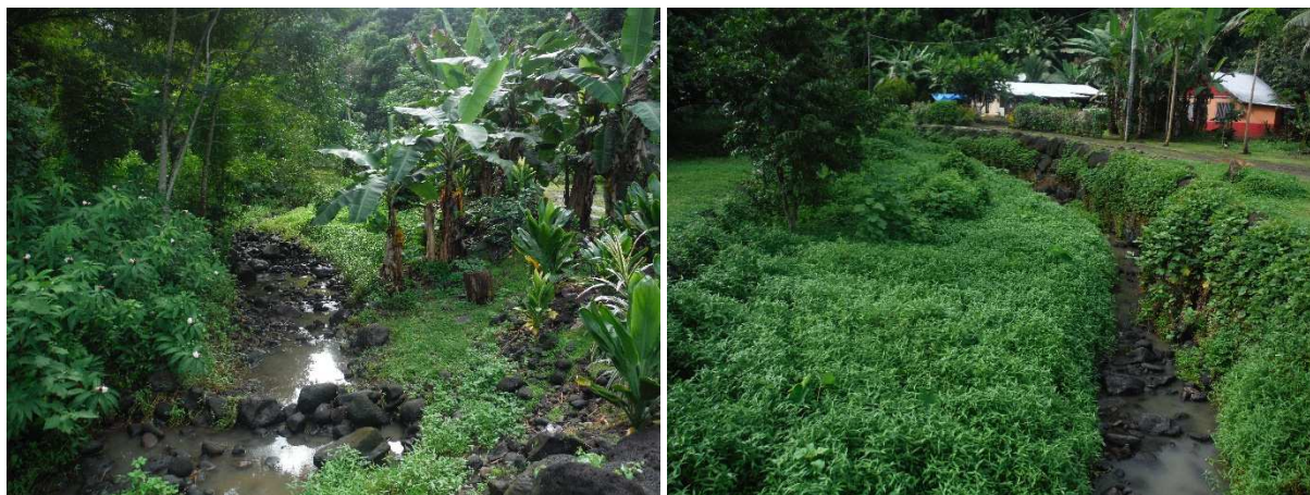
Photo 3 et 4. Section naturelle en amont (à gauche) et section enrochée du tronçon étudié avec atterrissement et développement de la végétation (à droite).
