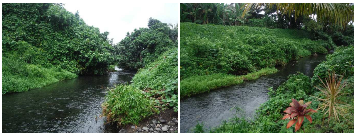
Photo 7 et 8. Chenal endigué sur les deux rives.
