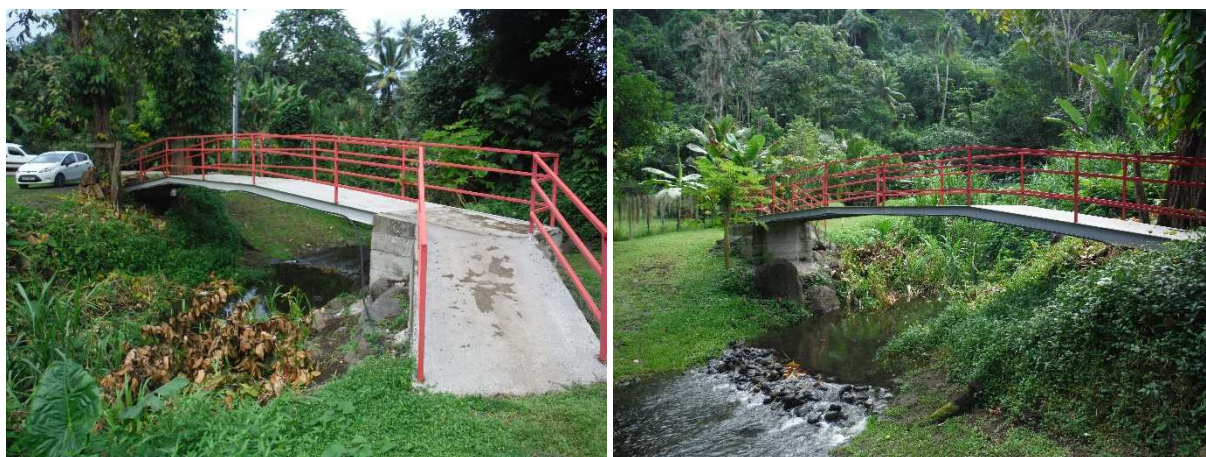
Photo 22 et 23 : Vue amont (gauche) et aval (droite) de la première passerelle piétonne.
