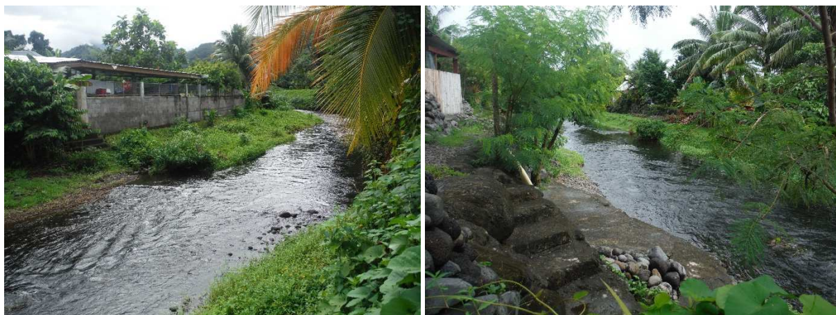
Photo 9 et 10. Constructions en bordure de chenal et atterrissements.
