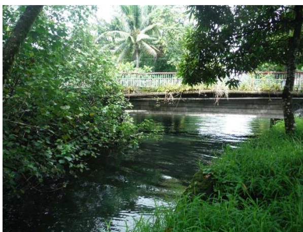
Photo 21 : Pont de la RDC sur la Potiaai.
