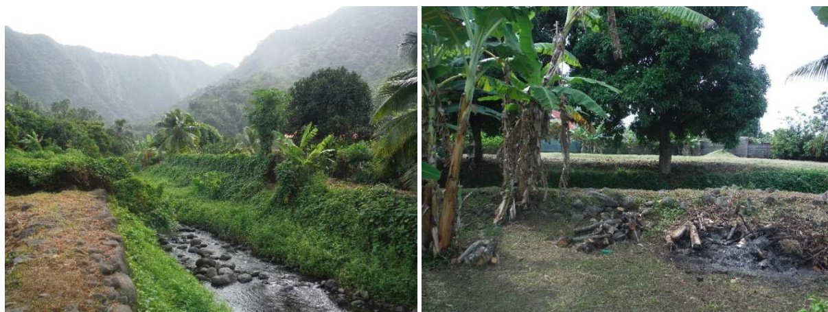
Photo 7 et 8. Rectification du chenal et endiguement de la rive droite
