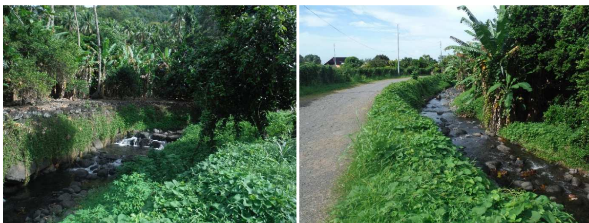
Photo 5 et 6. Enrochements des méandres
