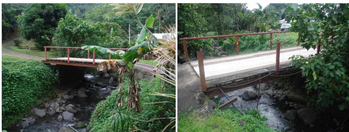
Photo 13 et 14. Vue amont et aval de la passerelle métallique.
