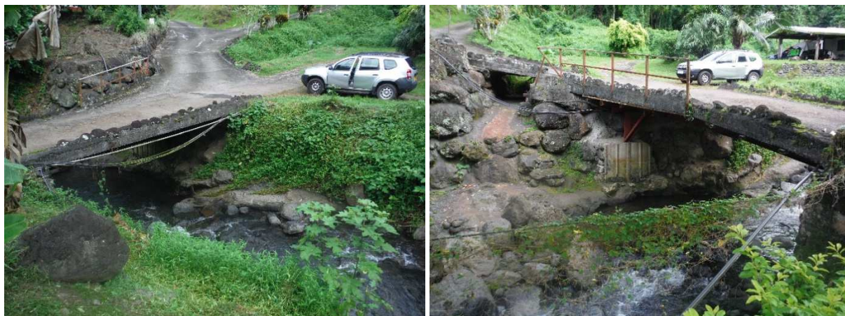
Photo 11 et 12. Vue amont et aval de la passerelle en béton.
