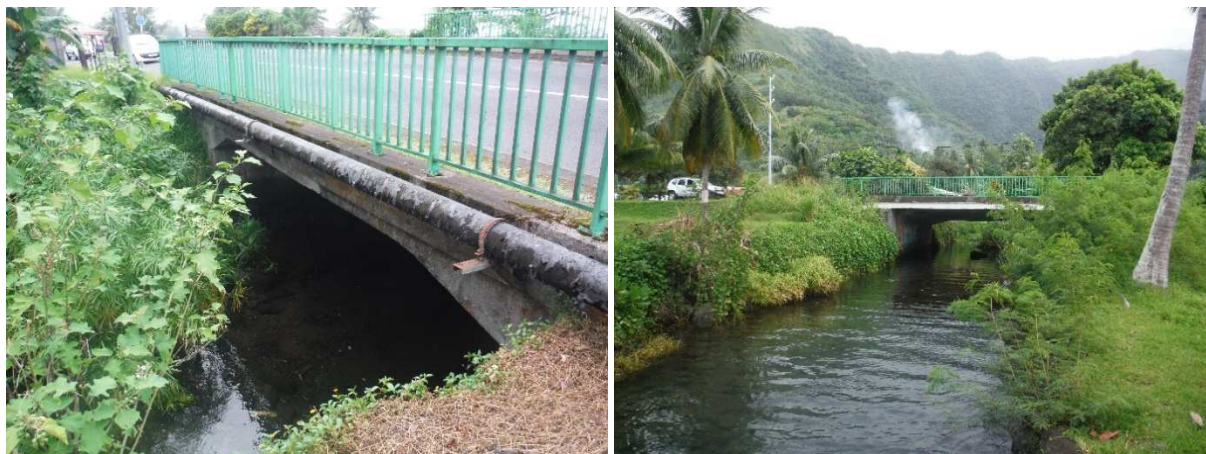
Photo 15 et 16. Vue amont et aval du dalot sous la RDC.
