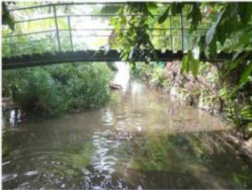
OH4 – ponceau avec hauteur limitée – Section 2.6 x 0.7m hauteur
