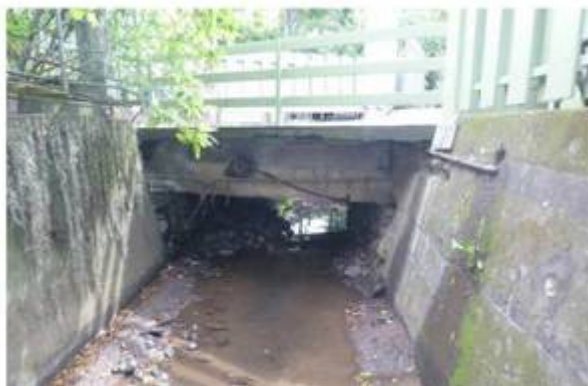
OH 7 – Ponceau (servitude) avec hauteur limitée – Section 2.25mx0.95 m hauteur
