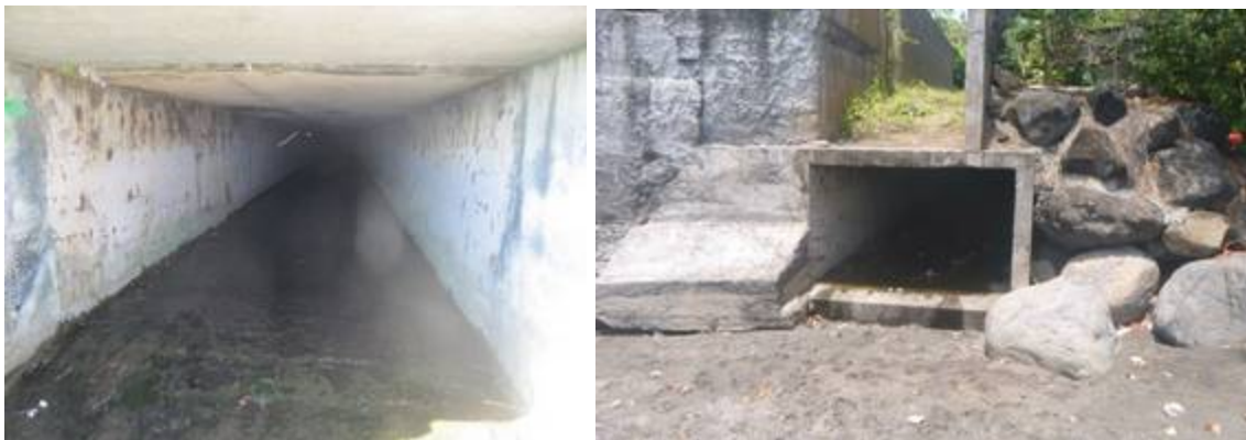
Figure 1-17 : Fort engravement sous l'ouvrage en sortie du dalot principal (photo à gauche source VAIAD – 2015 et à droite H20 - 2020)
