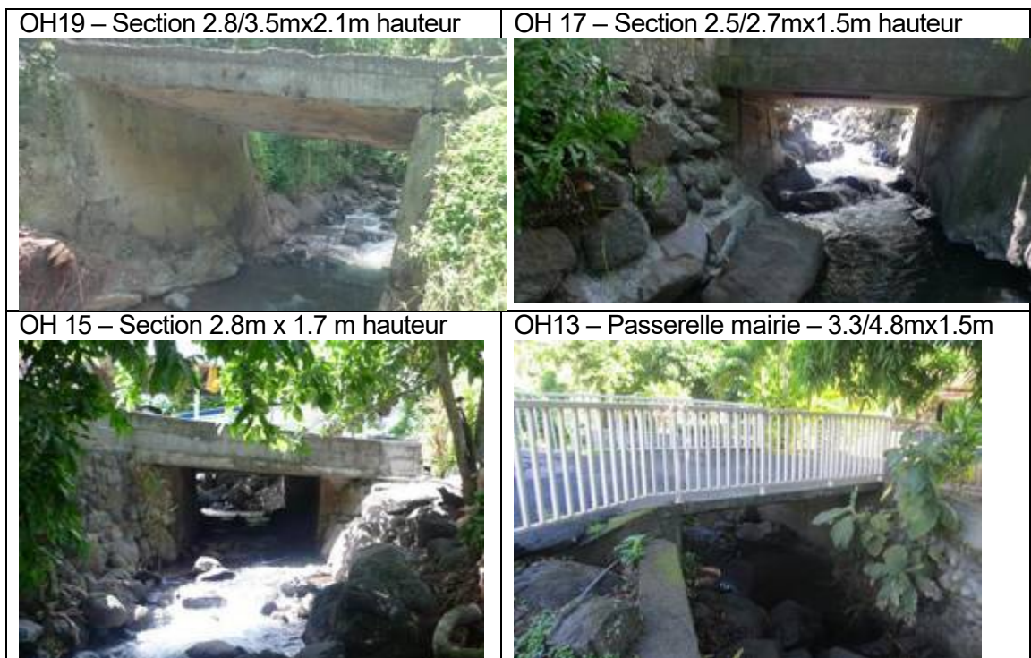
Figure 1-12 : Ouvrages sur tronçon habité en amont de la RDC (source photos AVP 2019 et mission terrain hydratec 2019)
