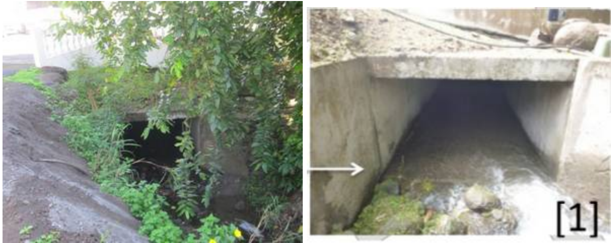
Figure 1-13 : Ouvrage d'entrée du dalot sous rond-point (photo hydratec 2019 à gauche et H2O 2017 à droite)
