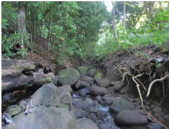
Photo 5 : vue vers l'amont – érosion verticale
