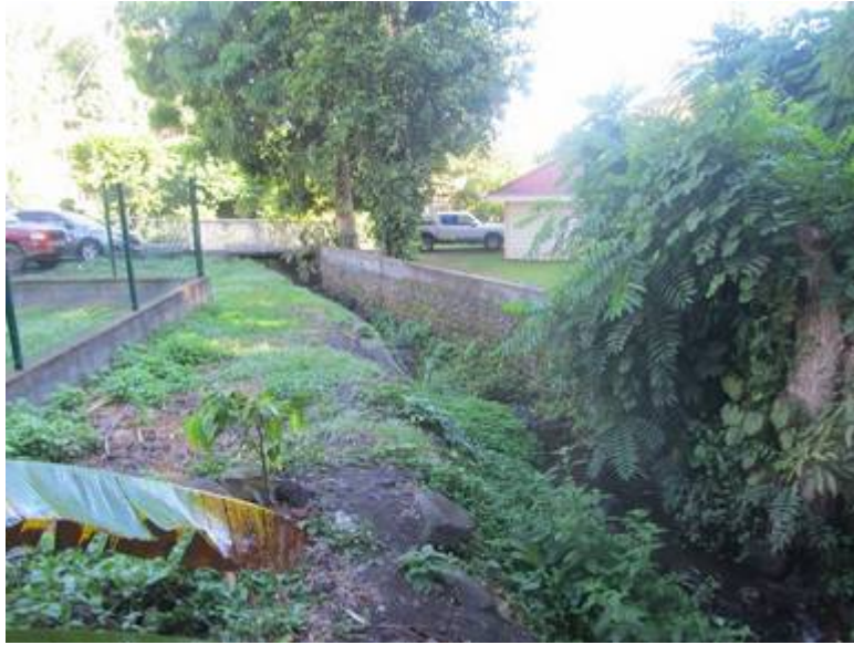
Photo 6 : aménagements de la rivière dans les zones urbanisées
