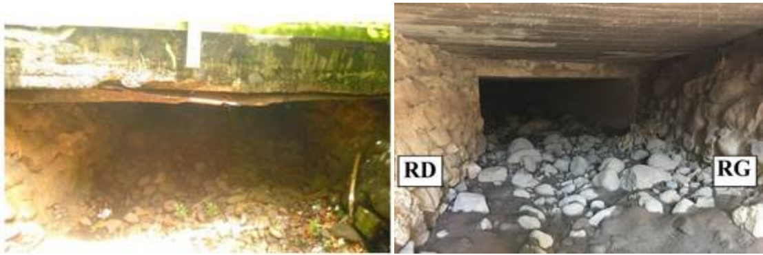
Figure 1-17 : Fort engravement sous l'ouvrage en sortie du dalot principal (photo à gauche source VAIAD – 2015 et à droite H20 - 2020)
