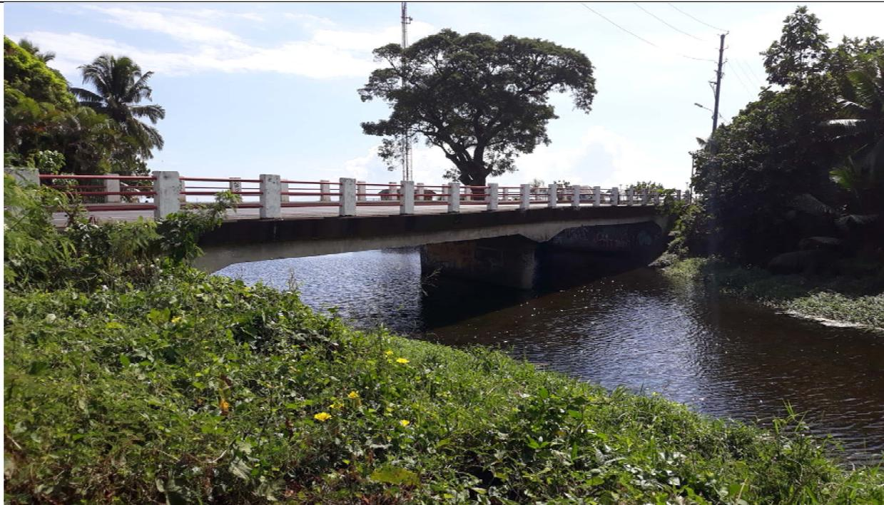
Le pont de la route de ceinture en aval est légèrement en biais par rapport à l'axe du cours d'eau. Il présente des dimensions importantes et une pile centrale.
