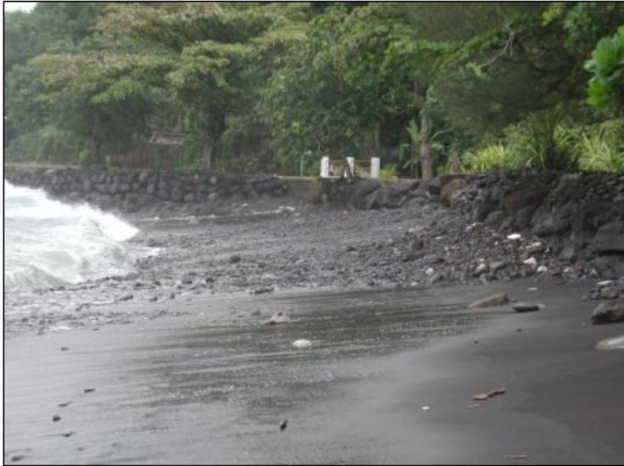
*Photo 1: accumulation de galets contre les enrochements protégeant la route dans le secteur de Vairao, lors d'une houle de 3-4 m de direction S-SW.*
