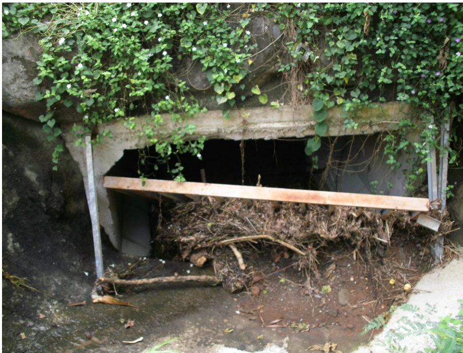
Figure 3 : Vue de l'ouvrage de dérivation le 20/05/2015
