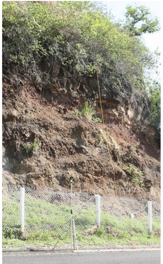
Figure 33 : Profil actuel du talus 11, dont le taux d'érosion n'est pas particulièrement élevé. Un paléosol sous-cave la tête de talus, sans qu'aucune déstabilisation n'ait encore eu lieu.
