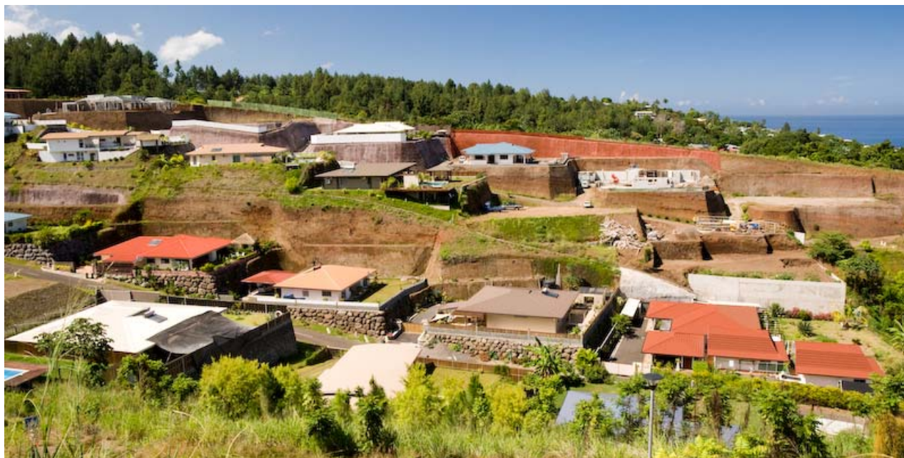
Figure 1 : Terrassements du lotissement des Hauts de Outumaoro à Faa'a (sur le versant au-dessus de l'université).
