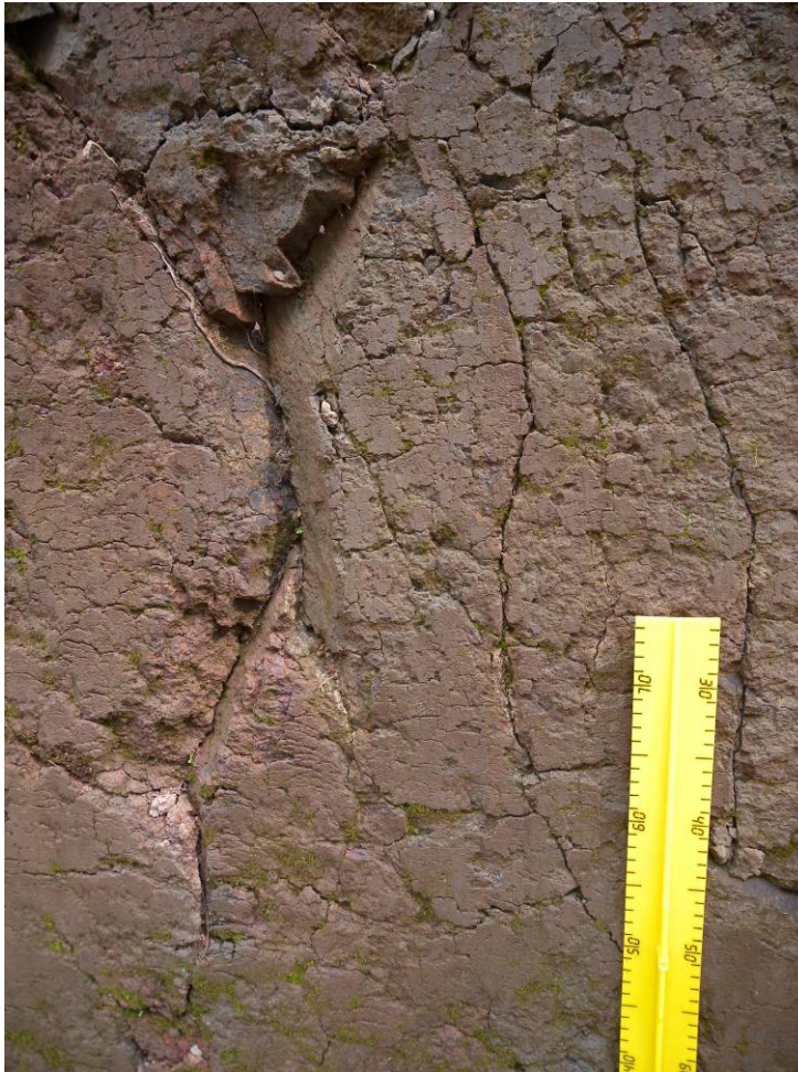
Figure 70 : Réseau de fissures de dessiccation sur les zones de Mamu III et IV.
