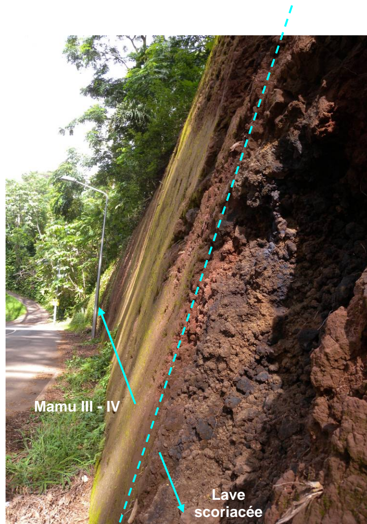
Figure 69 : Contraste de processus érosif selon la nature lithologique du talus.
