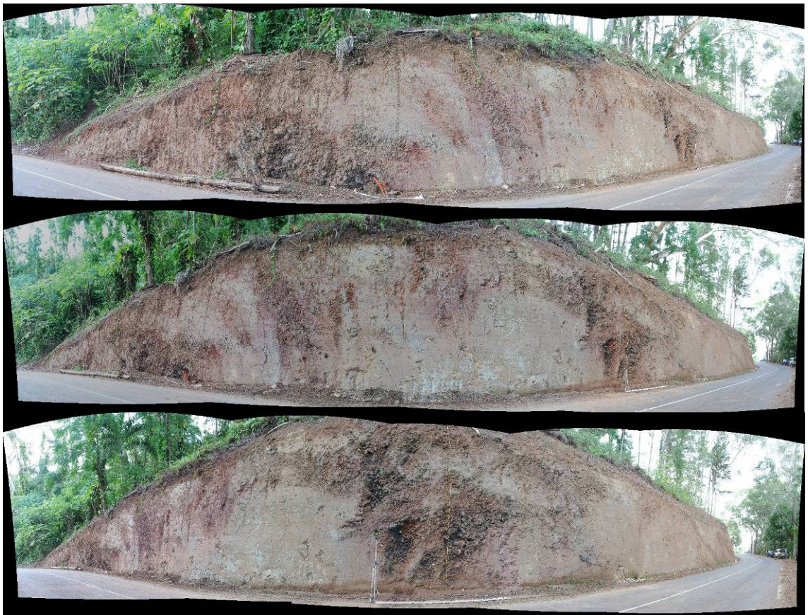
Figure 38 : Exemple de trois photos panoramiques contigües, prises le 13 août 2009, et documentant l'évolution du talus de Pamatai Huaiti sur la commune de Faa'a.
