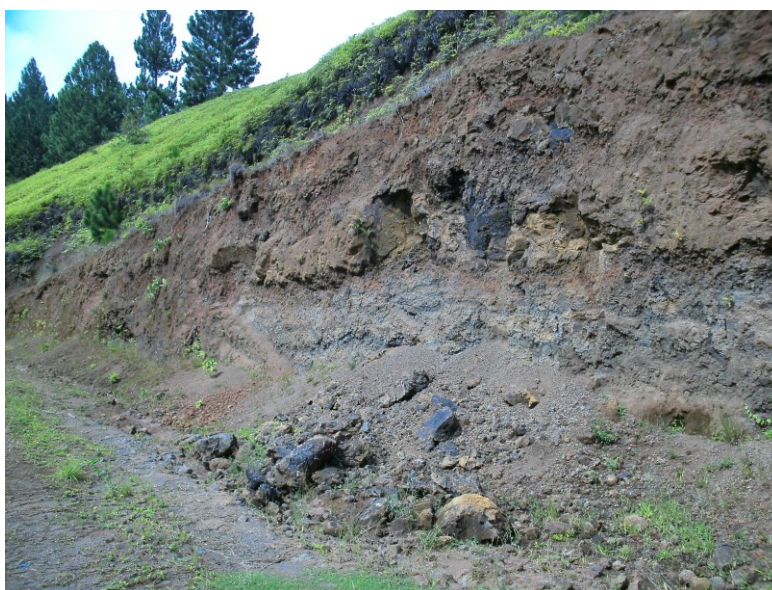
Illustration 21 : Forte et rapide dégradation d'un talus de mamu II. Site 14.
