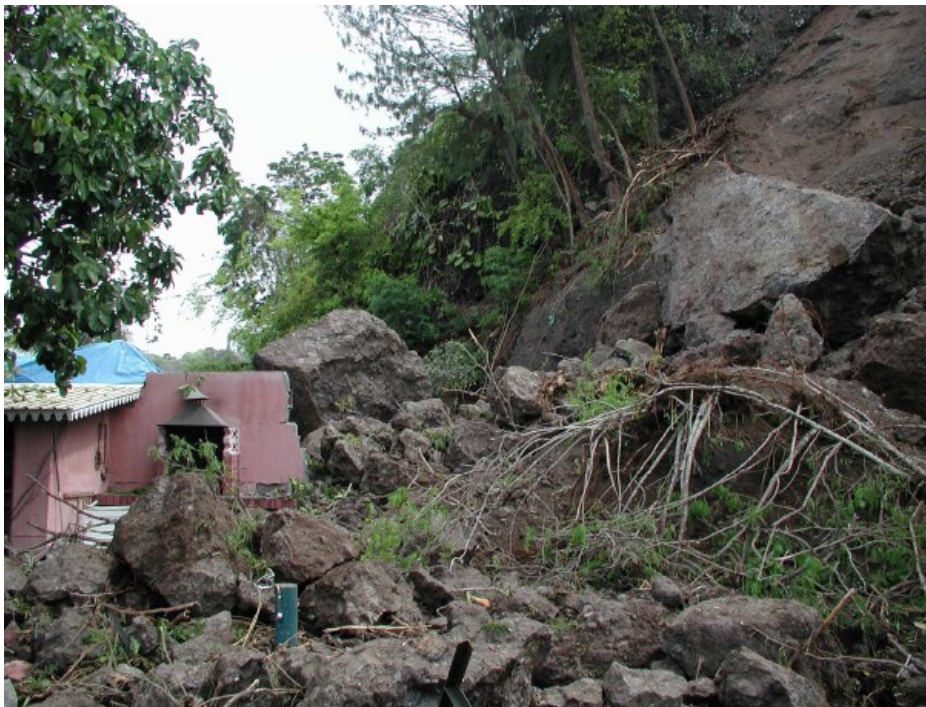
Illustration 2 : Eboulement au pk 14,9 en décembre 2002 (Source : Rapport de présentation du BRGM)
