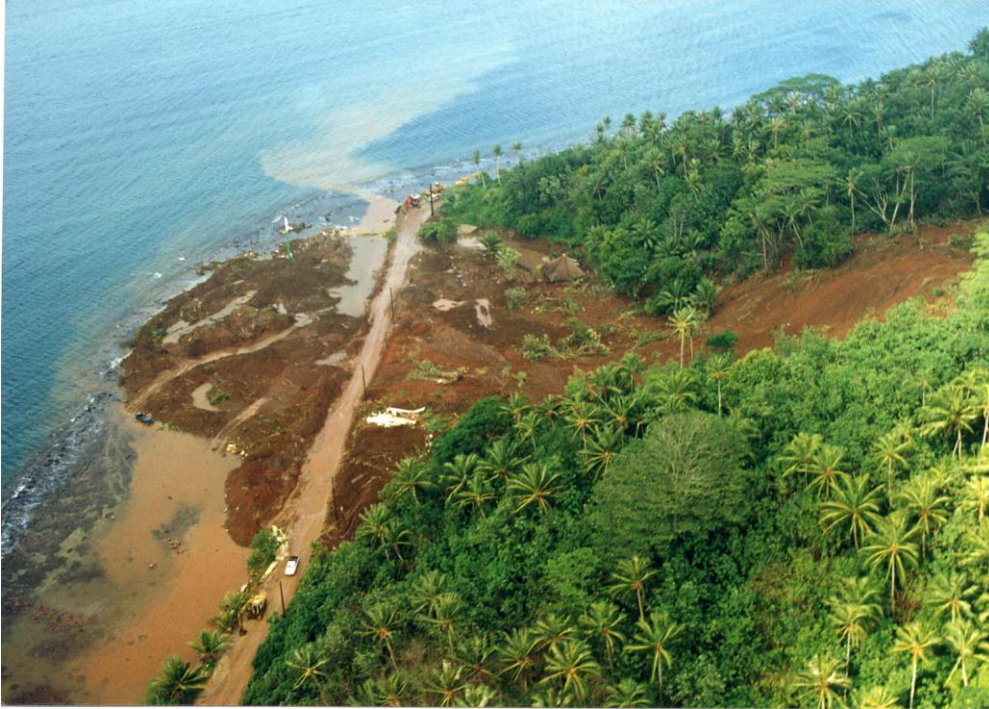
Figure 16 : Photo de la coulée du PK 5.7. Source : LTPP
