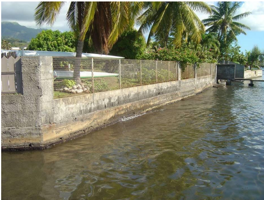
Figure 19 : Aménagement privé d'un mur en béton avec remblai sur petit fond (Commune d'Arue, ph. C. Chene)
