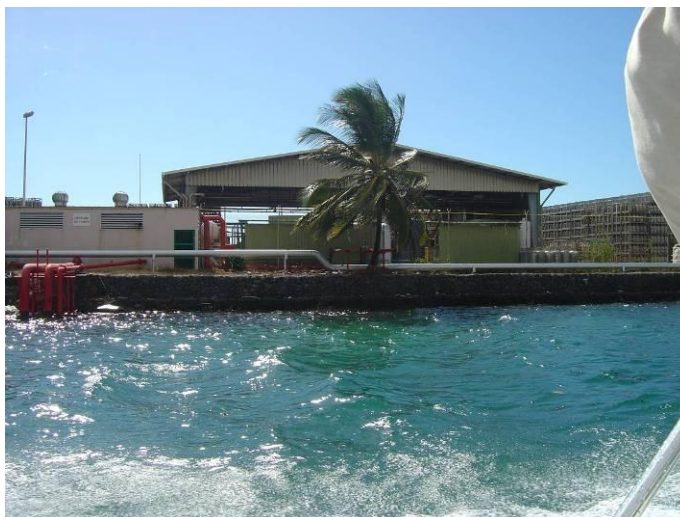
Figure 3: Structure portuaire maçonnée établie sur remblai ; Papeete (Ph. C. Chene)
