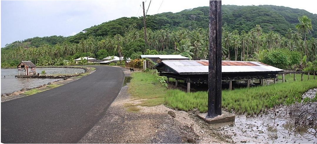
Figure 7: Route en remblai avec armature en enrochement (Tahaa) séparant le littoral de sa mangrove (M. Garcin 2005)
