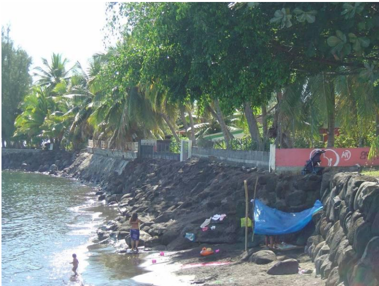
Figure 21 : Murs de bas de plage en enrochement cimenté (premier plan), non cimenté (second plan) (Commune d'Arue, plage publique, Ph. C. Chene)
