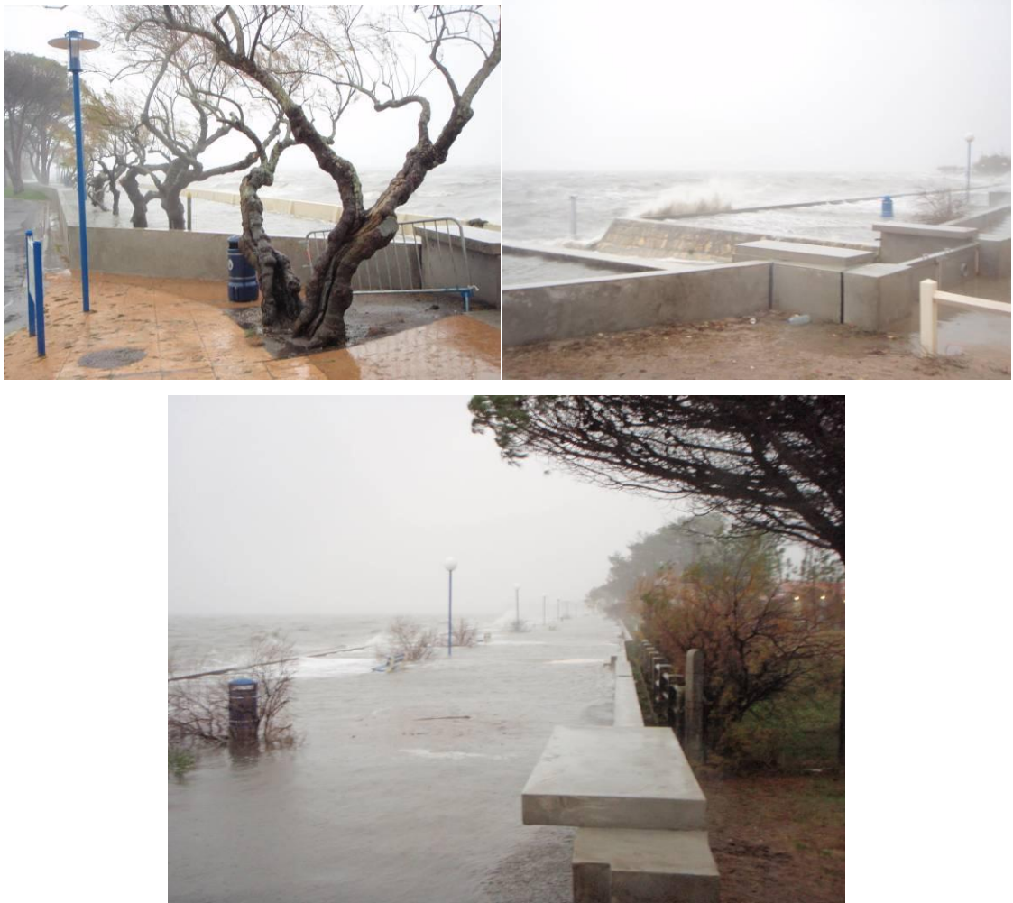
Figure 42 : Fonctionnement du système de protection contre la submersion marine pendant une tempête d'hiver à Andernos-les-Bains (Décembre 2011, photo. Observatoire de la Côte Aquitaine)
