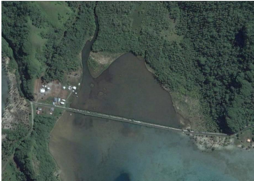
Figure 6 : Route sur remblai dans des zones de petits fonds longueur 500 m (Raïatea Sud, 2005, 2004 DigiGlobe)
