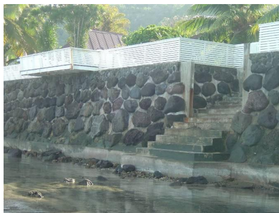
Figure 14 : Haut mur de bas de plage en enrochement cimenté avec balustrade, escalier et remblai (Commune de Paea, Ph . C. Chene)
