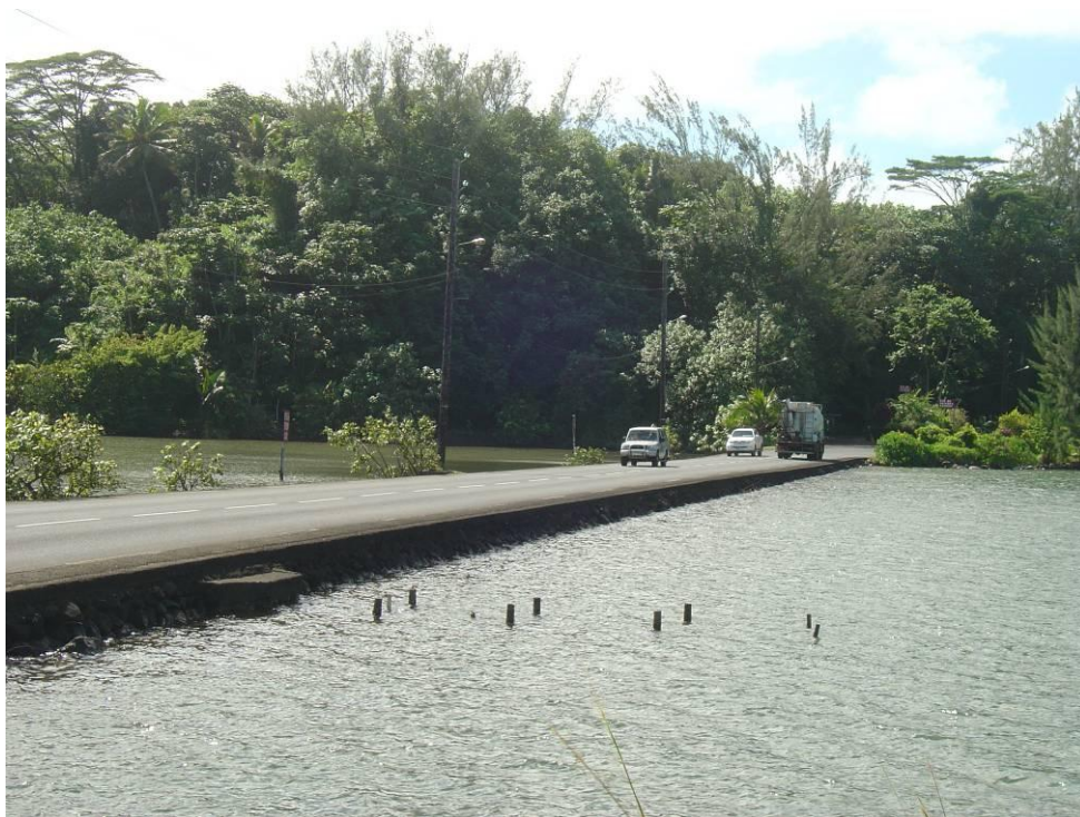
Figure 8 :Route sur remblai dans une zone de petits fonds (Tahiti, Teva i uta)
