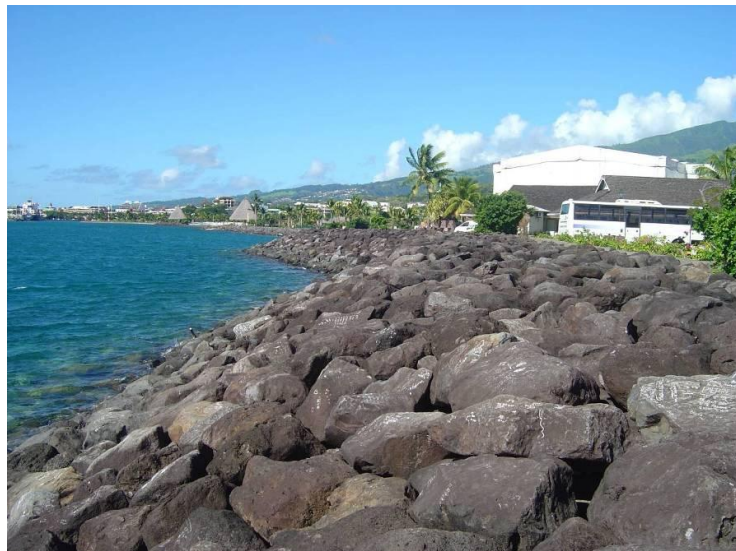
Figure 16 :Enrochements de grande ampleur et remblai en zone urbaine en zone de petit fond (Toa'Ta, Papeete, Ph. C. Chene)
