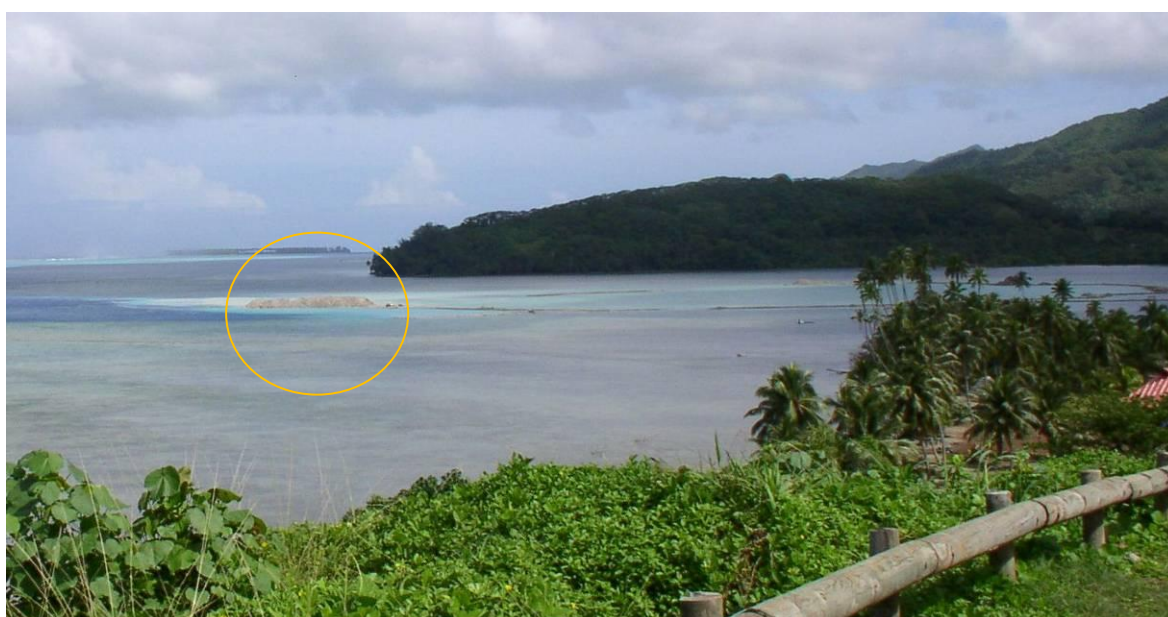
Figure 20 : Important remblais effectué sur le récif frangeant du Sud de Raiatea. Cet aménagement avance de 475m dans le lagon par rapport au littoral ; haut : image Digiglobe, la flèche indique l'axe de vue de la photo du bas (M.Garcin 2005)
