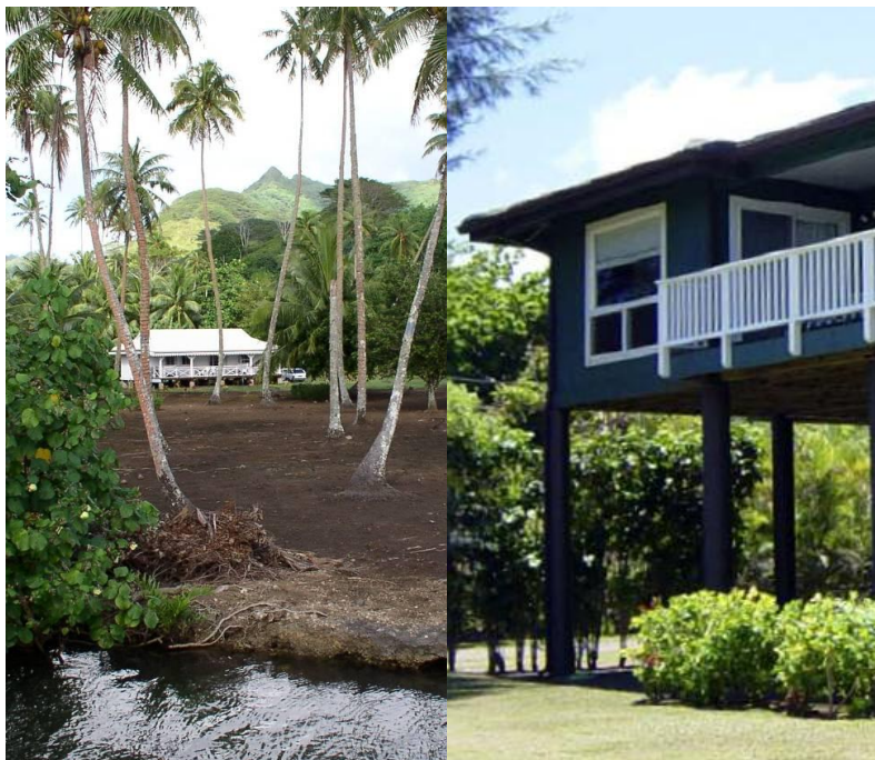
Figure 43 : Maison traditionnelle sur pilotis dans une zone inondable de Raiātea (Gauche, Photo. M. Garcin) . Maison moderne sur pilotis à Hawaii prenant en compte une forte hauteur de submersion (Photo Dolan Eversole)
