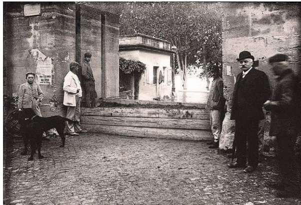
Figure 36 :Batardeau en planche de bois installé pour contenir une crue du Rhône au début du XXème siècle (Archives Municipales d'Avignon)
