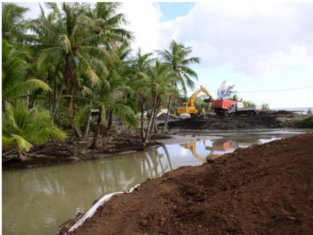
Figure 26 :Création de remblais dans des zones inondables littorales (Raïatea 2005, Ph. M.Garcin)
