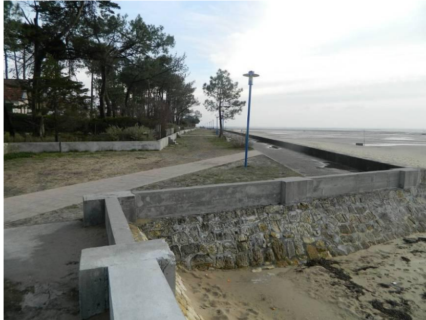
Figure 38 : Réhaussement de muret et ajout d'une seconde ligne de murets suite à Xynthia (Andernos-les-Bains, Photo Observatoire de la Côte Aquitaine)
