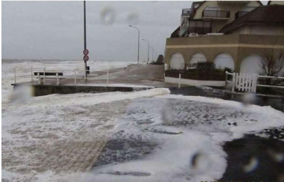
Figure 13 : Pénétration de la mer par une cale d'accès à la plage (Bernières-sur-Mer, 28 Février 2010, DDRM Calvados 2012)
