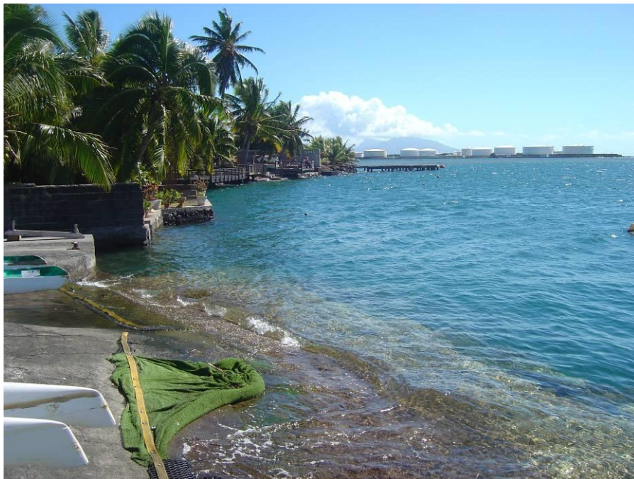
Figure 12 : Cale d'accès au lagon au premier plan, aménagements privés au second plan (mur et remblais), structures portuaires et industrielles à l'arrière plan (Papeete, Ph. C. Chene) – Artificialisation totale du trait de côte
