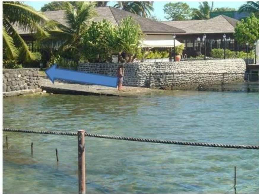
Figure 11 : Cale d'accès au lagon entourée par des murs maçonnés (Papeete, Ph. C.Chene). La flèche bleue indique l'axe de pénétration potentielle de la mer sous l'effet de la surcote et des vagues
