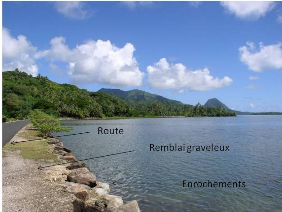
Figure 5 : Littoral aménagé avec route sur remblai et enrochements en petits fonds (Huahine, M. Garcin 2005)
