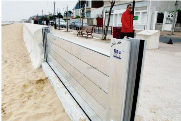
Figure 37 : Batardeau moderne (aluminium) installé en haut de plage suite à la tempête Xynthia (Châtelailon, Sud-Ouest)
