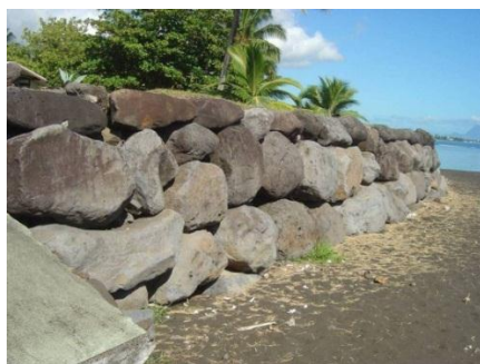
Figure 83. Mur en enrochement de haut de plage avec remblai et enjeux en arrière (Commune d'Arue Plage Lafayette, photo C. Chene). Figure extraite de Garcin (2012).
