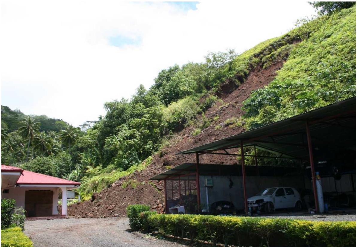
Figure 2.11 : Illustration du glissement de terrain intervenu au PK50 en février 2011
