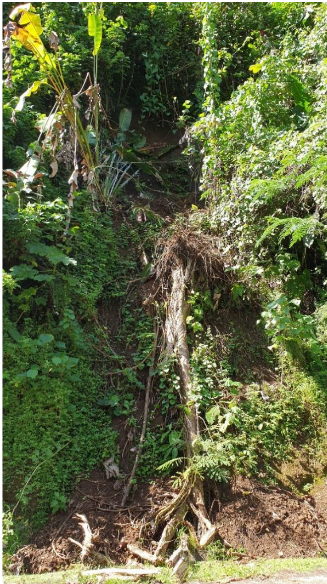
Figure 4.2: Exemple d'initiation de glissement engendré par la chute d'un arbre (coordonnées : X : 254391,6136 - Y : 8045600,9714)
