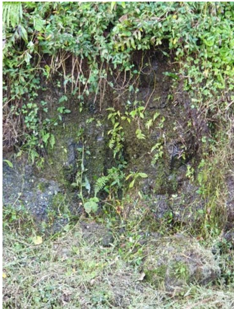
Figure 4 : Source en pied de falaise en bordure de route. A noter la présence de blocs (photo associée au point GPS n° 358).
