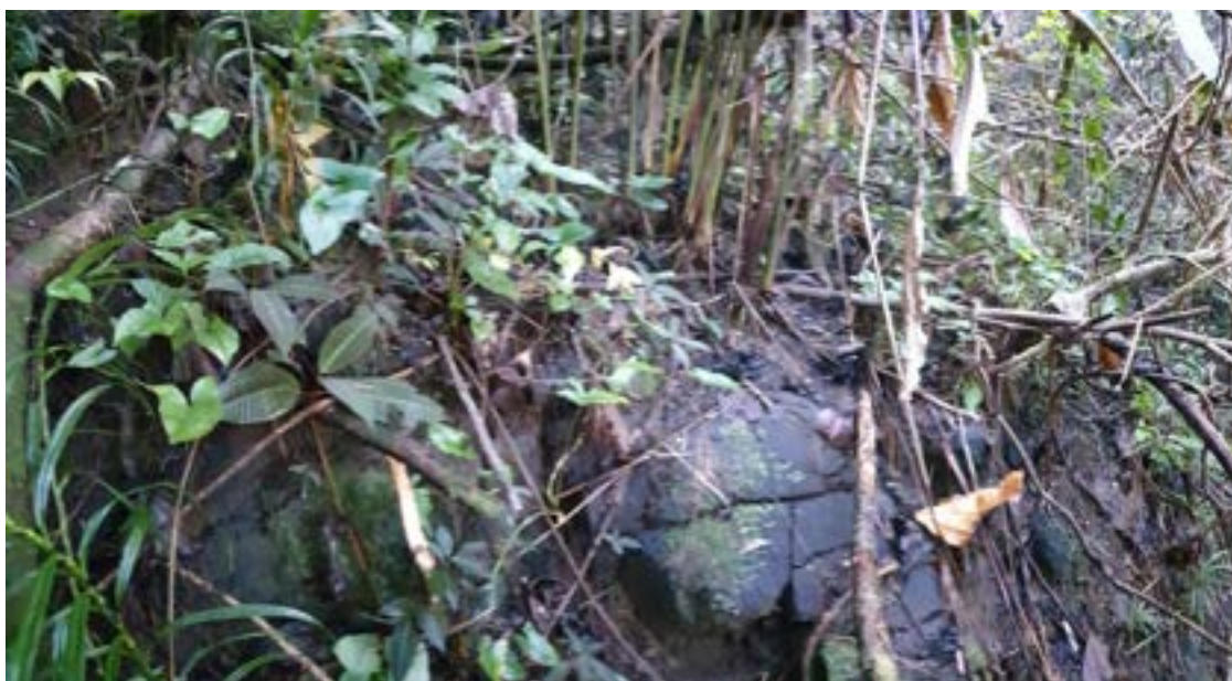
Figure 2 : Blocs métriques dans le talweg. Ces blocs actuellement sur les colluvions présentent un potentiel de glissement en cas de remobilisation des colluvions (photo associée au point GPS n°10).
