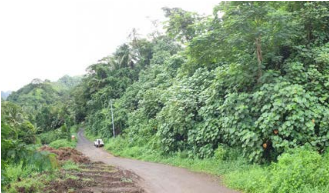
Figure 1 : Reste de matériaux glissés qui ont été déblayés suite au glissement de terrain de 2021 ici visible à gauche de la route (photo associée au point GPS n° 210).
