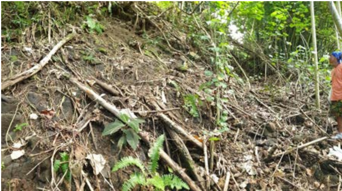
Figure 3 : Eboulement sur le chemin qui a joué le rôle de parade (volume estimé d'environ 75 m 3 ) (photo associée au point GPS n° 375).
