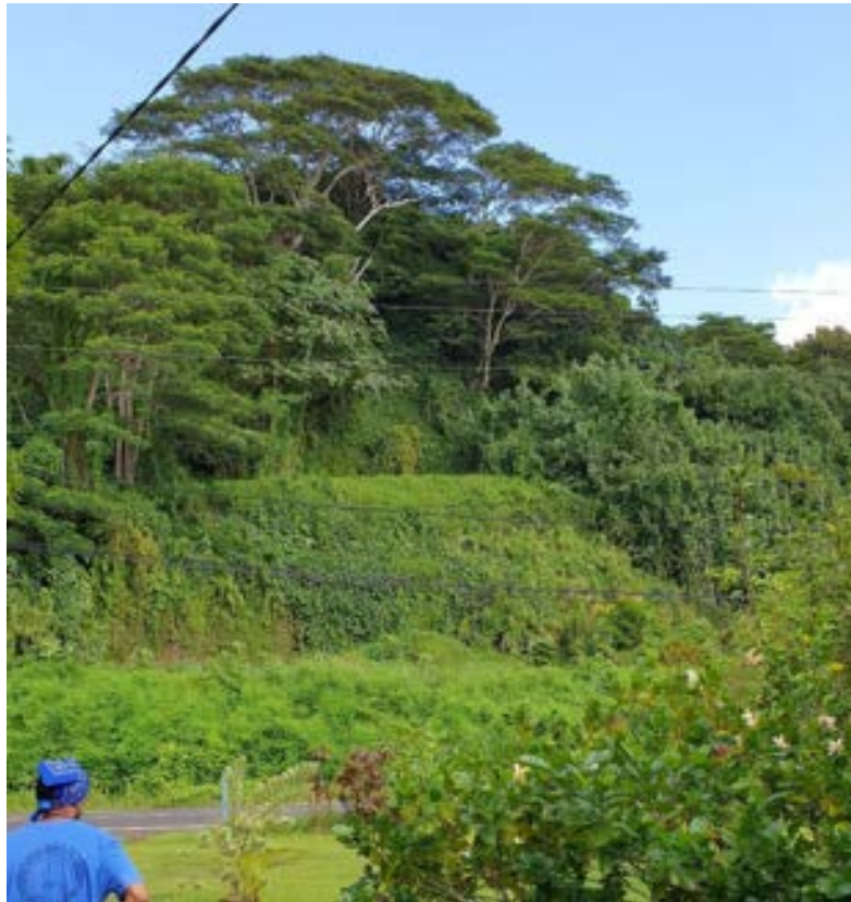
Figure 2 : Etat actuel du talus à partir duquel s'est initié le glissement de 1995 (photo associée au point GPS n° 451).
