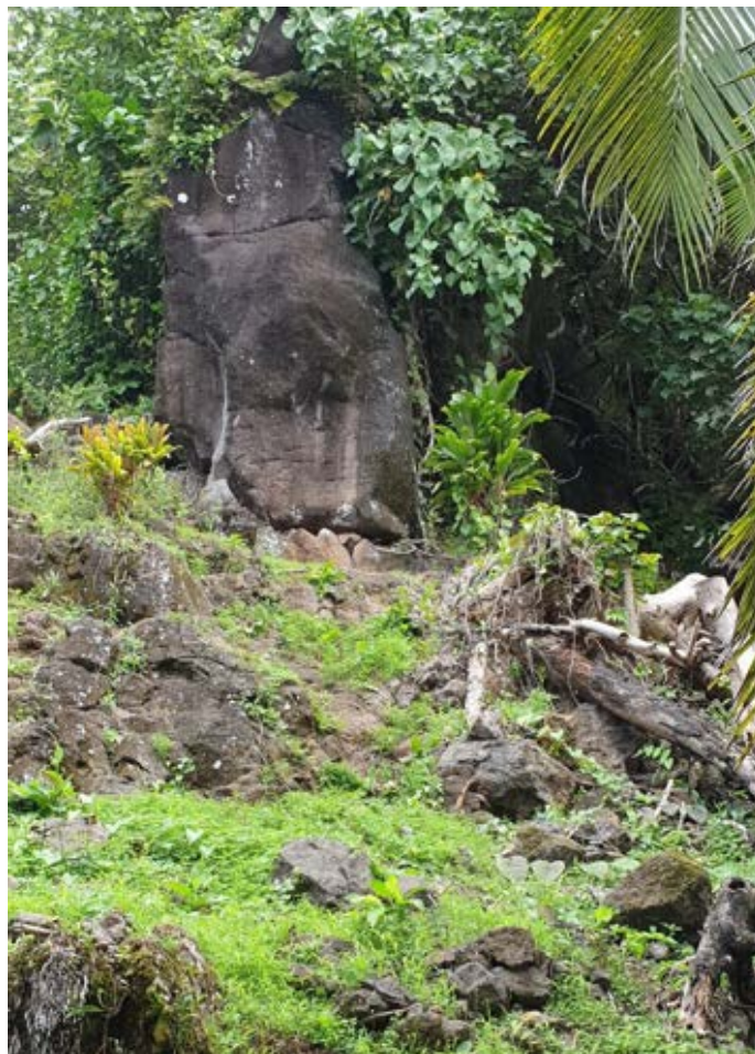
Figure 2 : Blocs au sol issus de précédents éboulements. Risque important de chute du bloc en arrière-plan (photo associée au point GPS n° 430).
