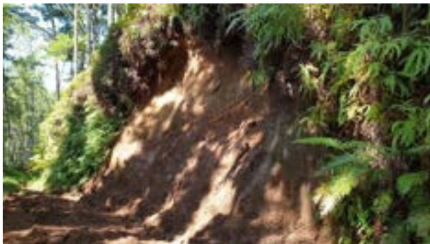
Figure 2 : Glissement récent de type G2 ayant été initié à partir d'une partie du talus de bord de chemin (photo associée au point GPS n° 94).
