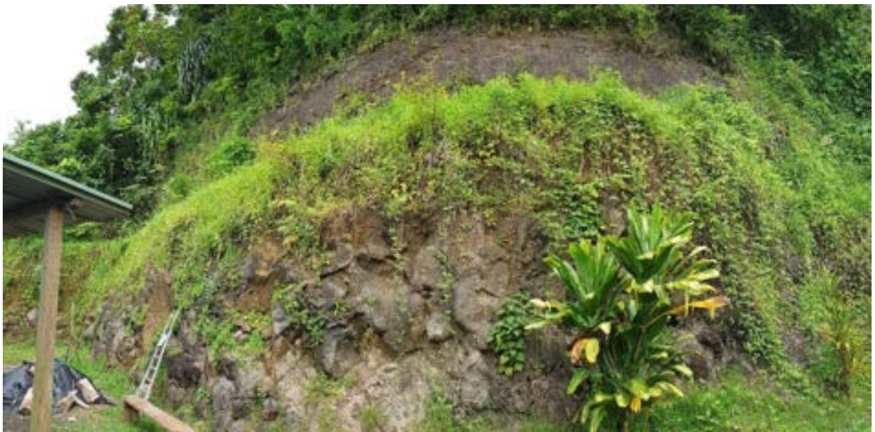
Figure 3 : Faciès de coulée basaltique fracturé sur les 5 premiers mètres à partir de la base puis faciès bréchique sur les 5 m supérieurs de la falaise, brèche de progression probable. Falaise de 10 m de hauteur avec un redan de 2m de large en milieu de falaise (photo associée au point GPS n° 299).
