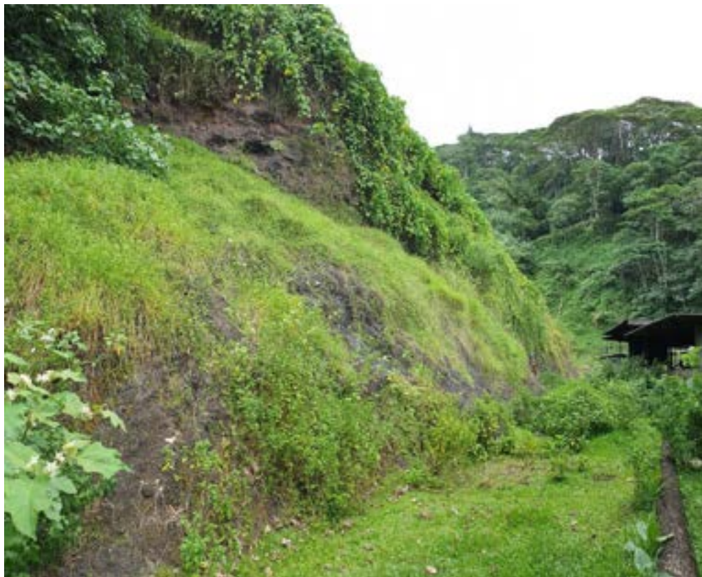
Figure 1 : Exemple d’affleurement de basalte qui forme des falaises de faibles hauteurs. Des blocs de taille décimétrique (non visibles sur cette photo) sont observés au sol en pied de falaise (photo associée au point GPS n° 397).
