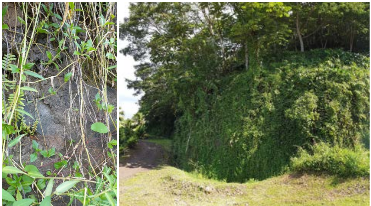
Figure 1 : Exemple d’affleurement de basalte visible ici dans un talus anthropique. Le talus présente une bonne tenue malgré une verticalité d’environ 75° en raison de la présence du niveau de basalte induré (photo associée au point GPS n° 402).
