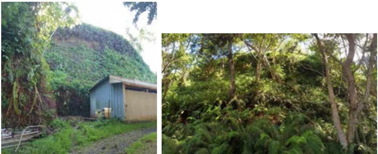
Figure 1 : Exemple de glissements de terrain répertoriés dans la BD_MVT (photo à gauche associée au point GPS n° 261, photo à droite associée au point GPS n° 260).
