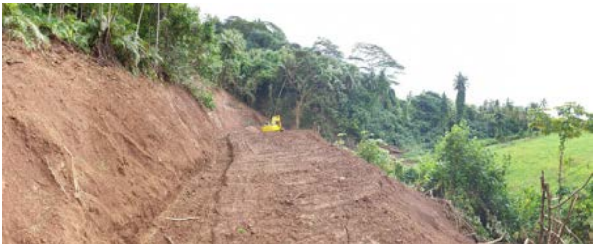
Figure 2 : Zone en cours d'aménagement (travaux de stabilisation) avec la création d'un ensemble de redans dans des faciès de mamu III / IV (photo associée au point GPS n° 18).
