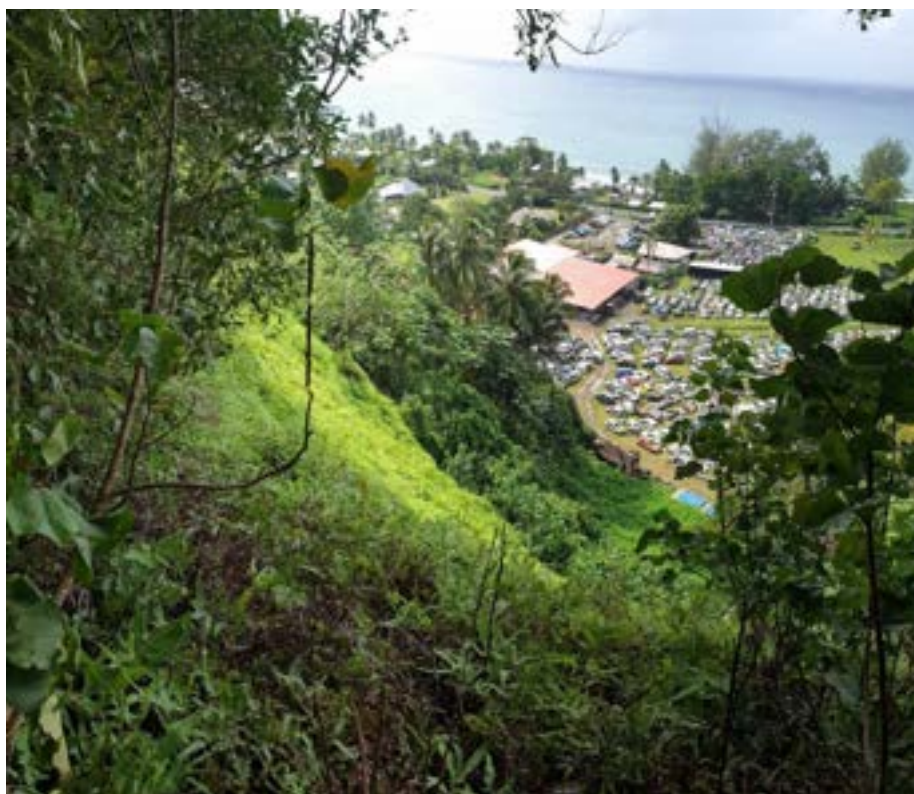
Figure 2 : Vue du sommet de colline située au-dessus de la casse automobile. Les falaises en contre-bas ont une pente très forte. La partie supérieure de la colline est constituée d'un terrain meuble de type mamu III - IV (photo associée au point GPS n° 326).
