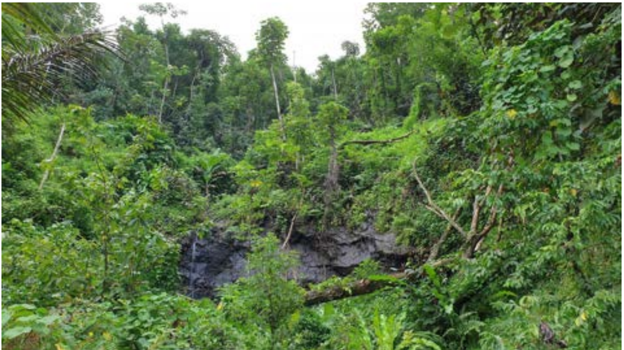
Figure 2 : Zone d'arrachement du glissement de terrain de 2021. On remarque la présence de falcatas emportés lors du glissement (photo associée au point GPS n° 211).
