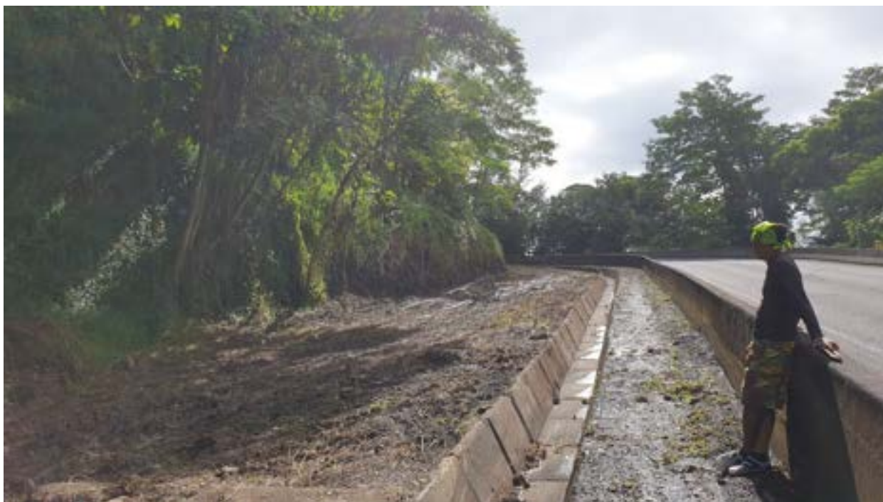
Figure 5 : Vue générale sur les aménagements effectués en bordure de la route ceinture (photo associée au point GPS n° 209).
