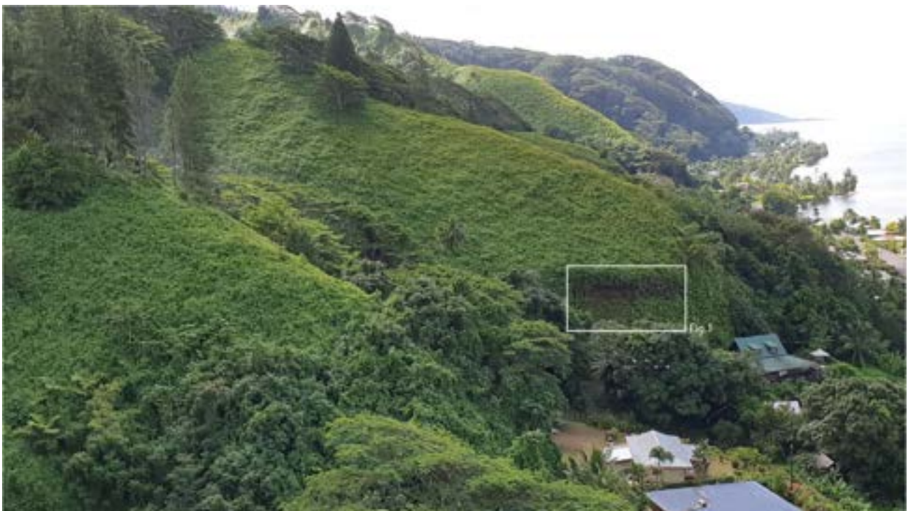
Figure 2 : Exemple de morphologie au niveau de l'emprise de la fiche. Les zones couvertes par les fougères sont nombreuses. Le glissement illustré par la photo de la Figure 1 à gauche est ici replacé dans son contexte par l'encadré blanc (photo associée au point GPS n° 285).
