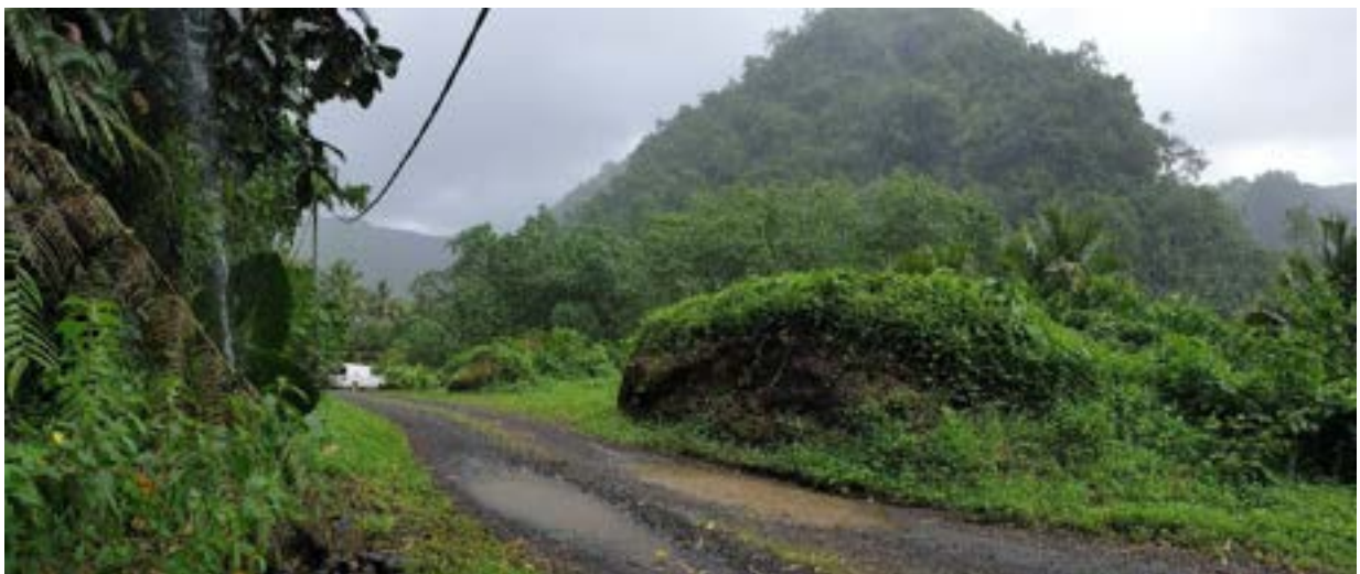
Figure 2 : Exemple de blocs éboulés d'un volume estimé à 150 m 3 (photo associée au point GPS n° 339).
