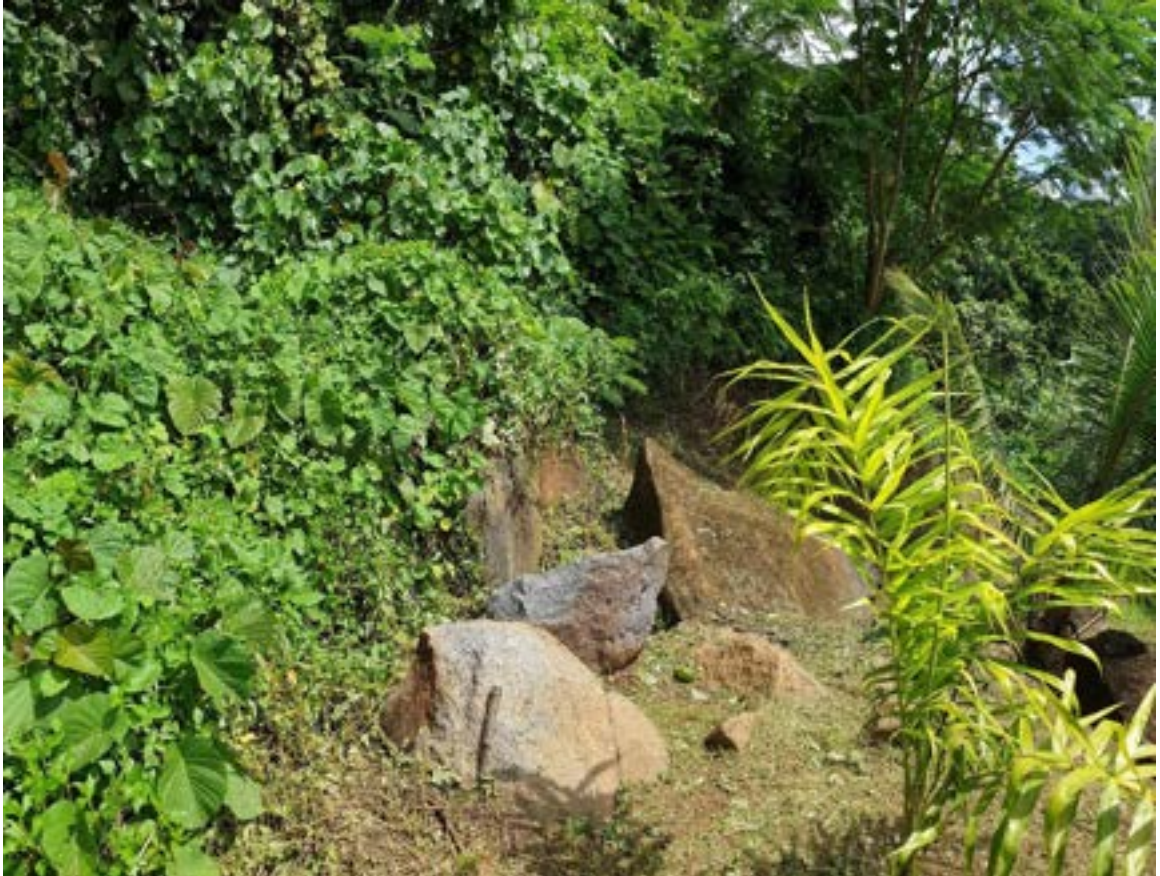
Figure 6.5: Blocs issus d'éboulements successifs (photo associée au point GPS n°429)
