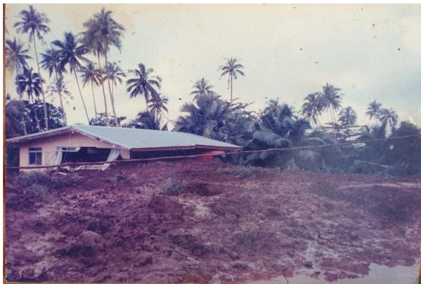
Figure 1 : Photographies fournies par les habitants illustrant le glissement de terrain de 1995 ayant eu lieu sur la commune de Hitiaa (photo associée au point GPS n°451).
