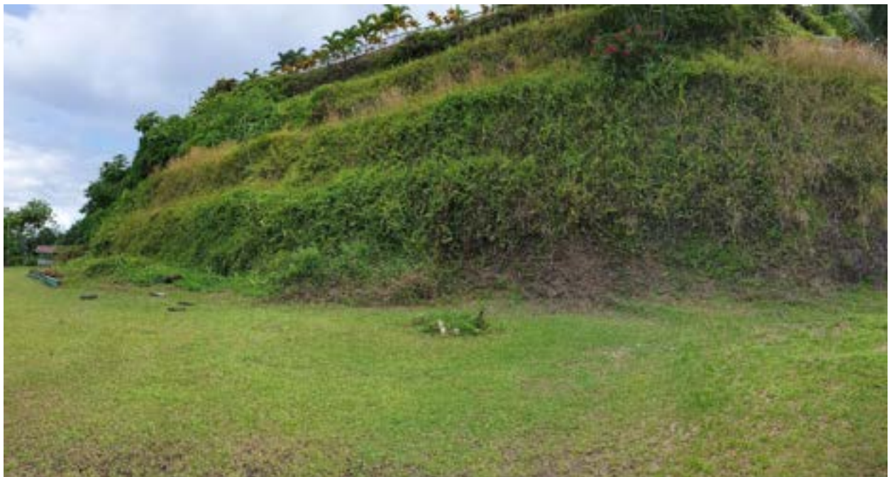
Figure 4 : Exemple de zone aménagée en une série de paliers. Le basalte est affleurant en pied de talus (photo associée au point GPS n° 405).
