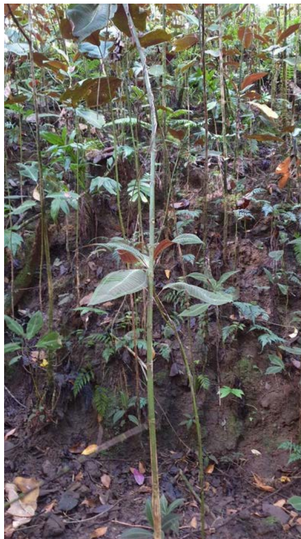
Figure 3 : Exemples de dépôts de glissements en pied de pente. Ces dépôts sont constitués d'un mélange de terre (sol), mamu et de blocs de taille variable (photo d'en haut associée au point GPS n° 117; photo d'en bas associée au point GPS n° 152).
