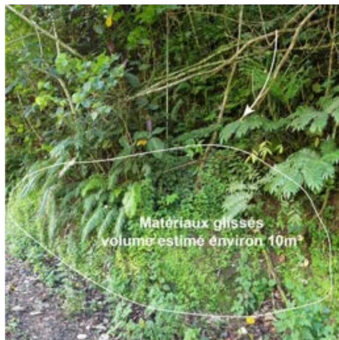
Figure 2 : Exemples de cône en pied de pente de petite taille correspondant à un glissement récent modéré de type G2 (photo associée au point GPS n° 108, évènement répertorié dans la BD_MVT).
