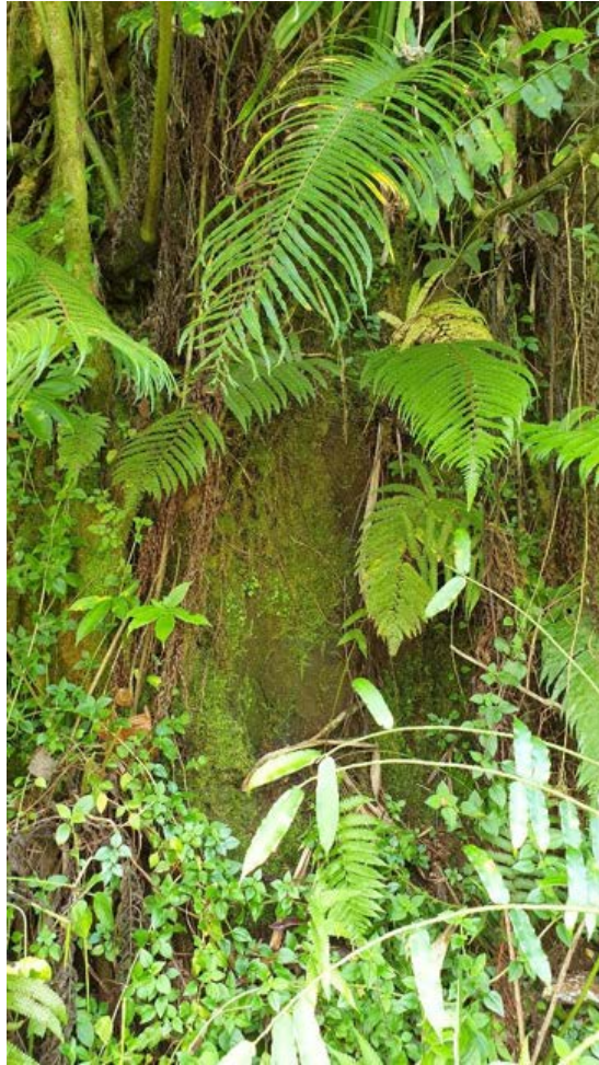
Figure 3 : Affleurement de basalte fracturé, altéré et très friable (photo associée au point GPS n° 107).
