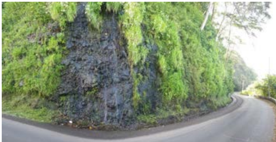
Figure 3 : Cascade sur la route. A noter le caractère fracturé du basalte (photo associée au point GPS n° 360).
