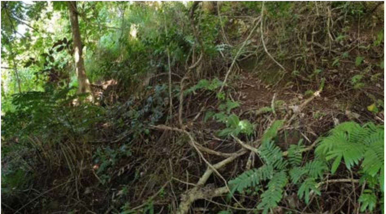
Figure 1 : Exemple de glissements de terrain répertoriés dans la BD_MVT (photo associée au point GPS n° 48).
