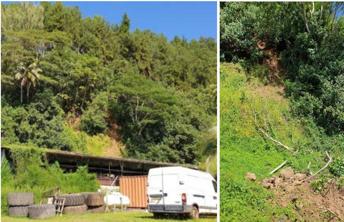
Figure 3 : Glissement récent de type G2 ayant remobilisé une partie du bas de pente (photo associée au point GPS n° 97).
