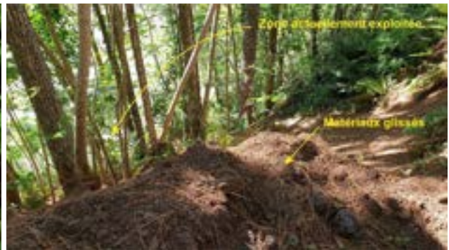
Figure 2 : Glissement récent de type G2 ayant été initié à partir d'une partie du talus de bord de chemin (photo associée au point GPS n° 94).
