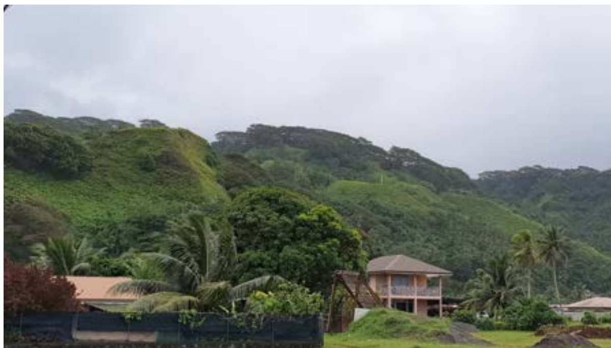
Figure 4 : Vue sur une partie des reliefs de l'emprise de la fiche. On note la différence de morphologie entre des parties sommitales composées de mamu de type III et IV (zones de fougères) déjà largement mobilisées par d'anciens glissements (considérées comme partiellement stabilisées maintenant) et les zones instables où un volume conséquent est encore disponible pour d'éventuelles remobilisations (photo associée au point GPS n° 318).
