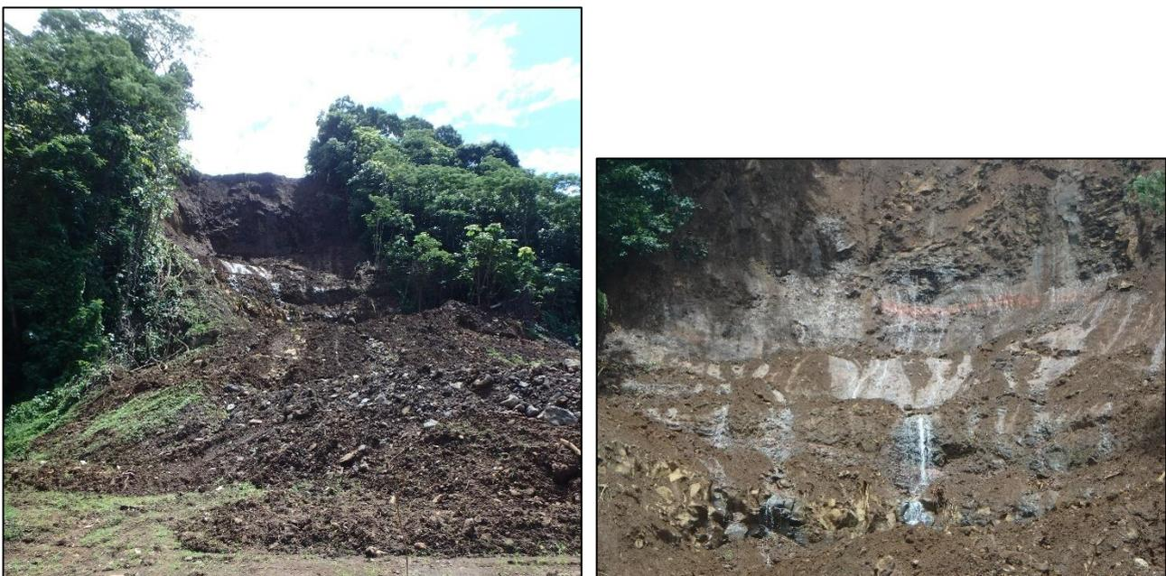
Figure 47 : Glissement de terrain dans les mamus complètement altérés
