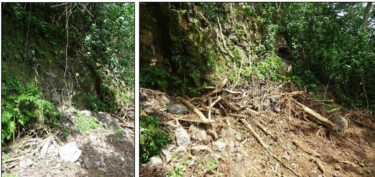
*Figure 67 : Chutes de blocs suite à des terrassements réalisés pour la création d'un chemin d'accès
