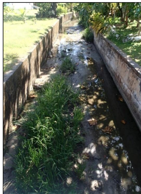
Figure 9 : Exemple d'aménagements réalisés sur les cours d'eau (Village de Moerai - Mars 2016)
