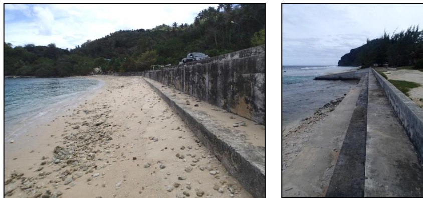
Figure 13 : Exemple de protections sous forme de mur A gauche Village d'Avera, à droite, Village d'Hauti - Mars 2016
