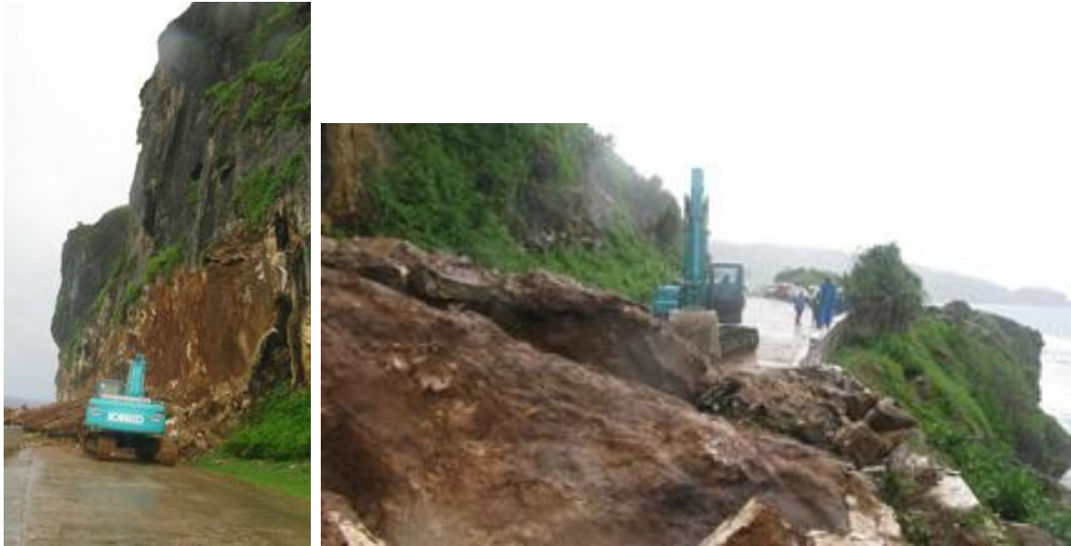
Figure 5 : Eboulement au Nord du village de Moerai (Février 2009)- Source Site Internet La Dépêche
