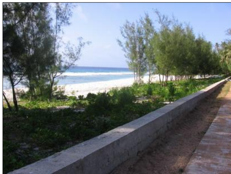
Figure 10 : Exemple d'aménagement sur le littoral d'Anapoto : muret protecteur
