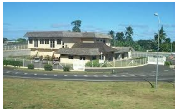
Station d'épuration de Punaauia
