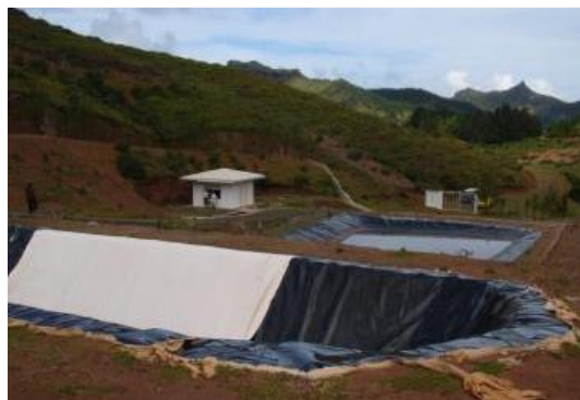
Centre d'Enfouissement Technique de Rapa
