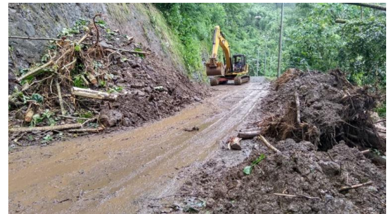
Déblaiement d'une route suite à un glissement de terrain à Fa'aone
