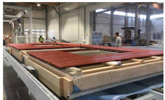
Préfabrication de panneaux de façade en épicéa dans une usine scandinave
