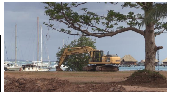
Aménagement d'un remblai dans les Îles du Vent
